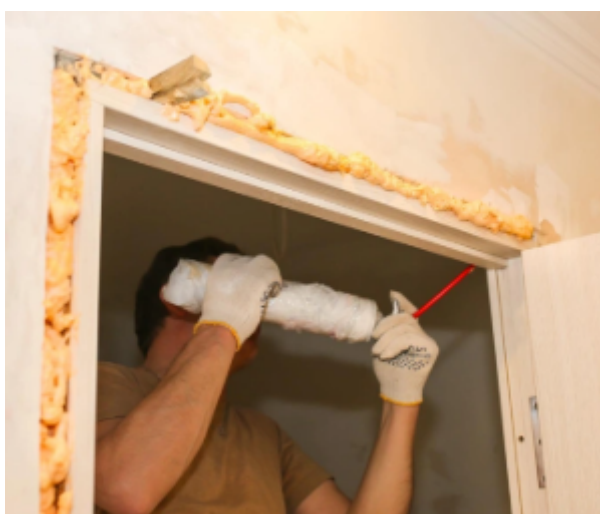
Figura 16 preenchimento total do perímetro da porta com espuma expansiva a base de PU
