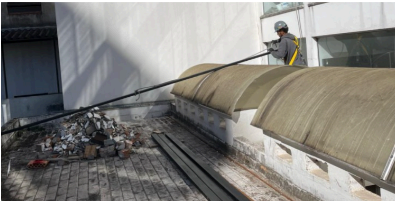
Figura 3 - Zenitais a demolir e fechar com laje pré-moldada (fonte: acervo da UFCSPA)
