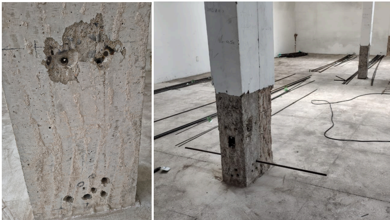
Figura 8 - Fixação de armaduras nos pilares, segundo pavimento (fonte: acervo da UFCSPA)
