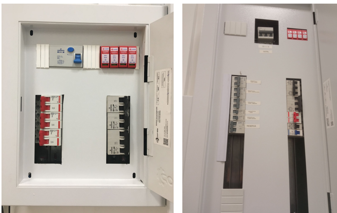
Figura 9 - Instalação de disjuntores termomagnéticos
