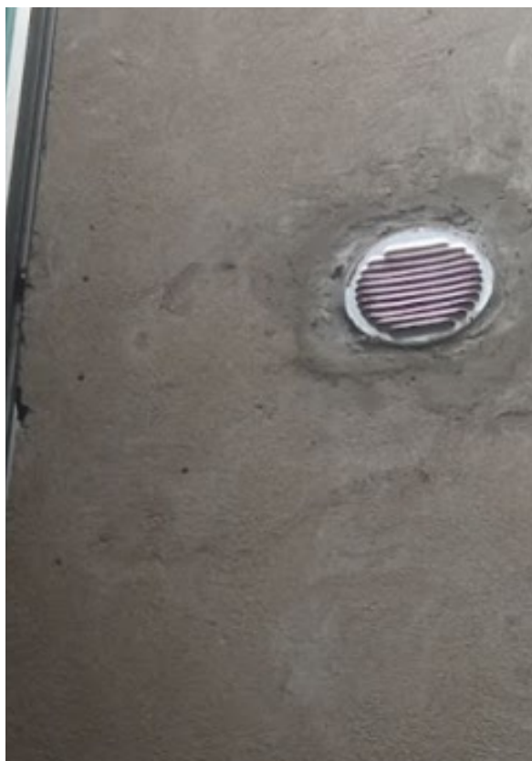
Figura 10 - Instalação de grelha de retorno em alumínio
