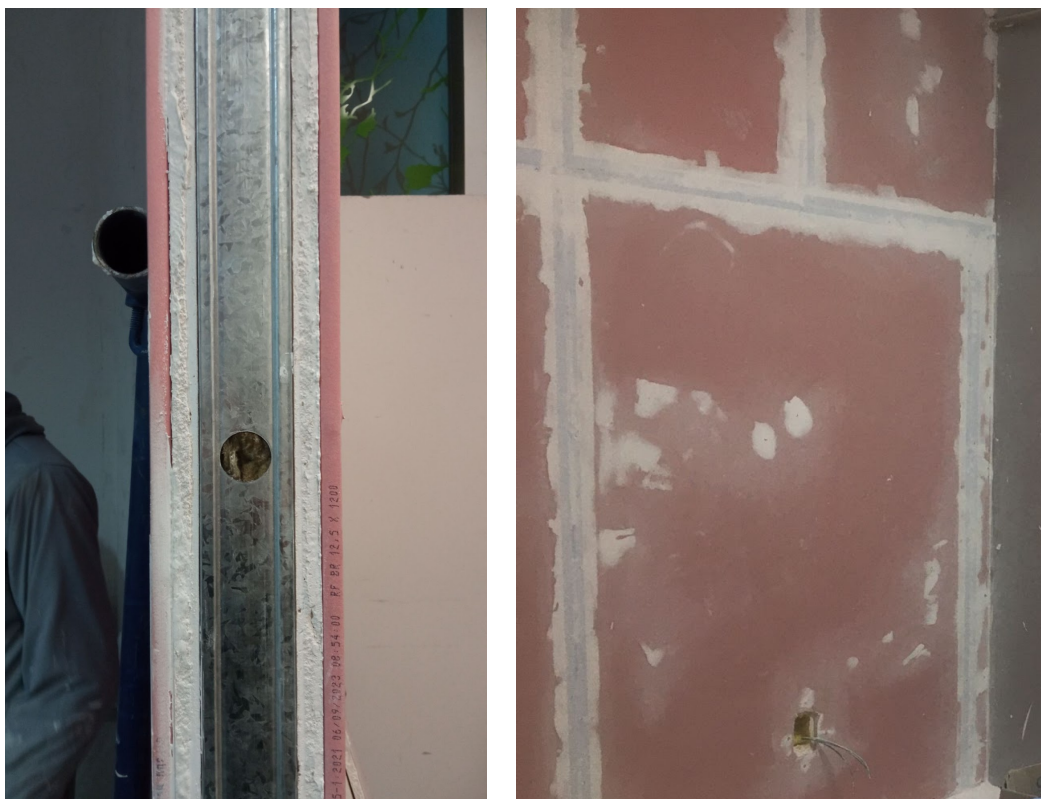
Figura 4 - Fixação de placa de gesso em parede existente
