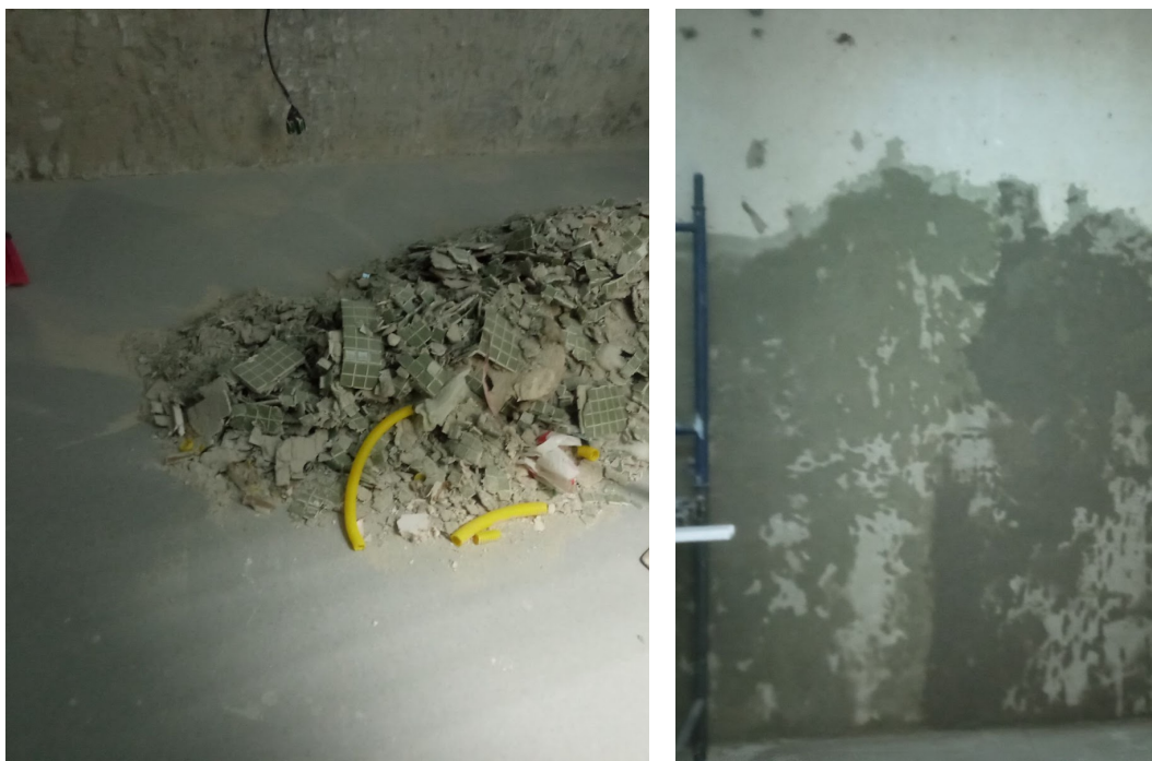
Figura 1 - Demolição de revestimento cerâmico e execução de massa única em argamassa
