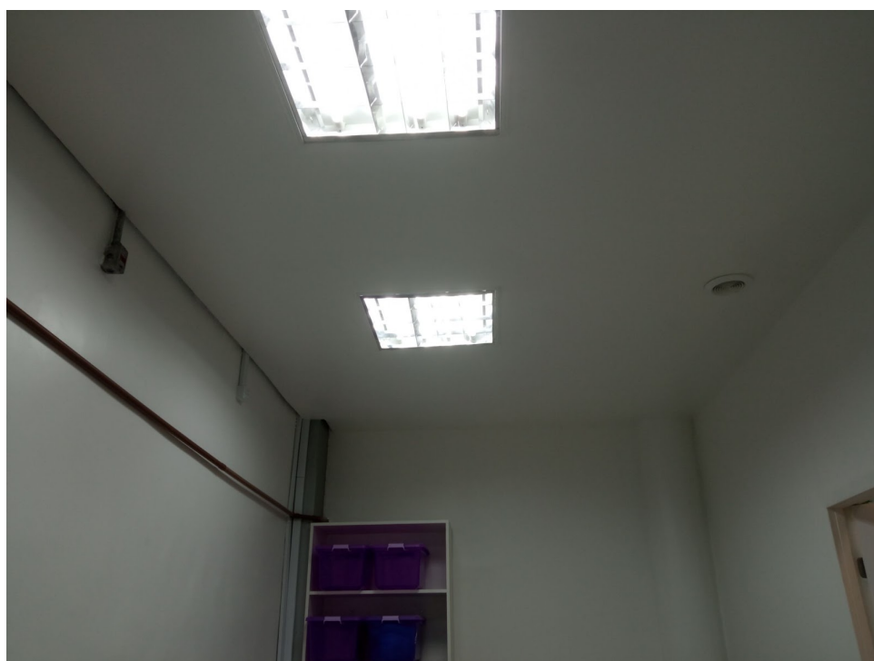
Figura 7 - Instalação de luminária
