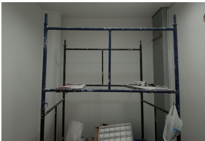
Figura 2 - Montagem e desmontagem de andaime
