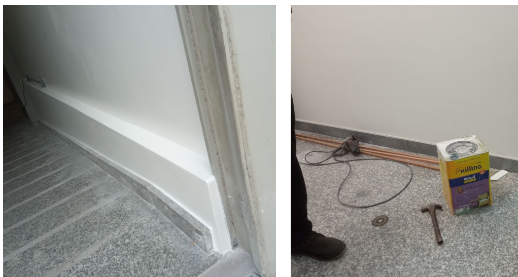
Figura 5 - Instalação de rodapé em granito
