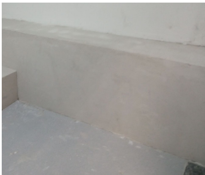
Figura 12 - Impermeabilização de superfície com argamassa polimérica
