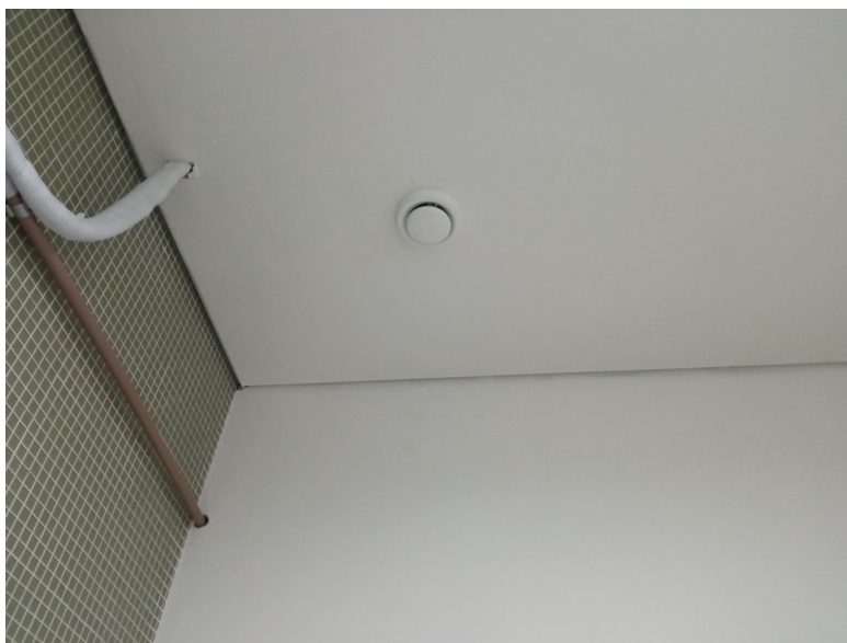
Figura 10 - Instalação de difusores de ar
