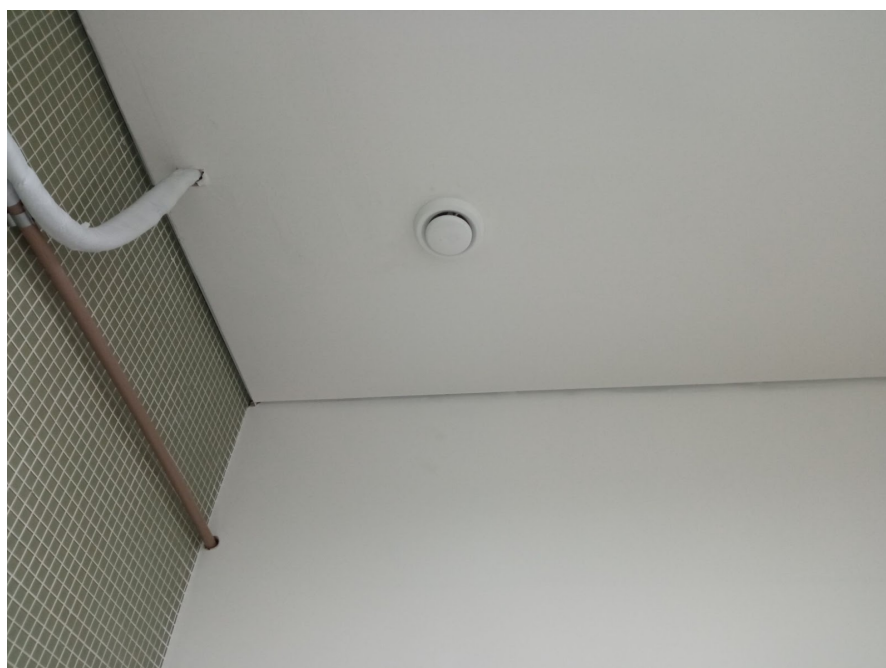
Figura 8 - Instalação de difusor de ar
