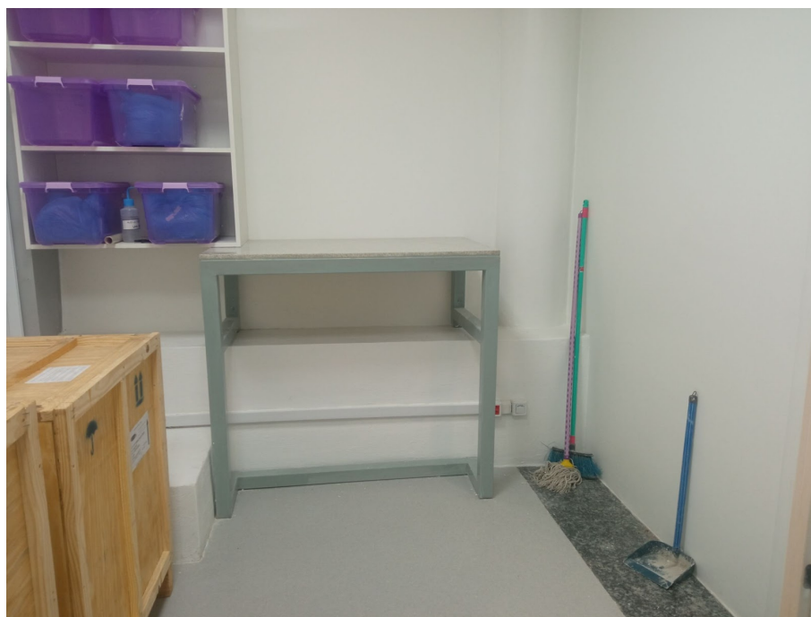
Figura 14 - Prateleira em MDF e bancada em metalon, com tampo de granito instaladas
