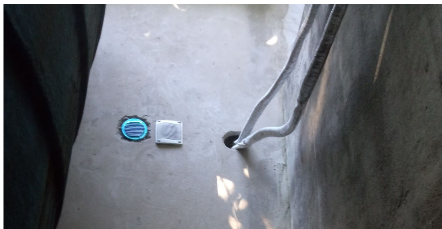
Figura 9 - Instalação de grelha (área externa)
