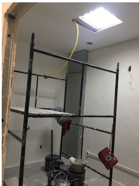
Figura 1 - Montagem de andaime, passagem de cabos elétricos e emassamento de paredes com massa PVA.
