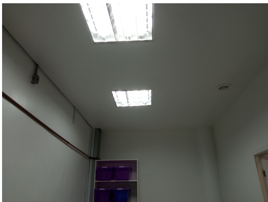
Figura 10 - Instalação (sem acabamento) de luminárias, instalação de micro ventilador e fechamento de alçapão
