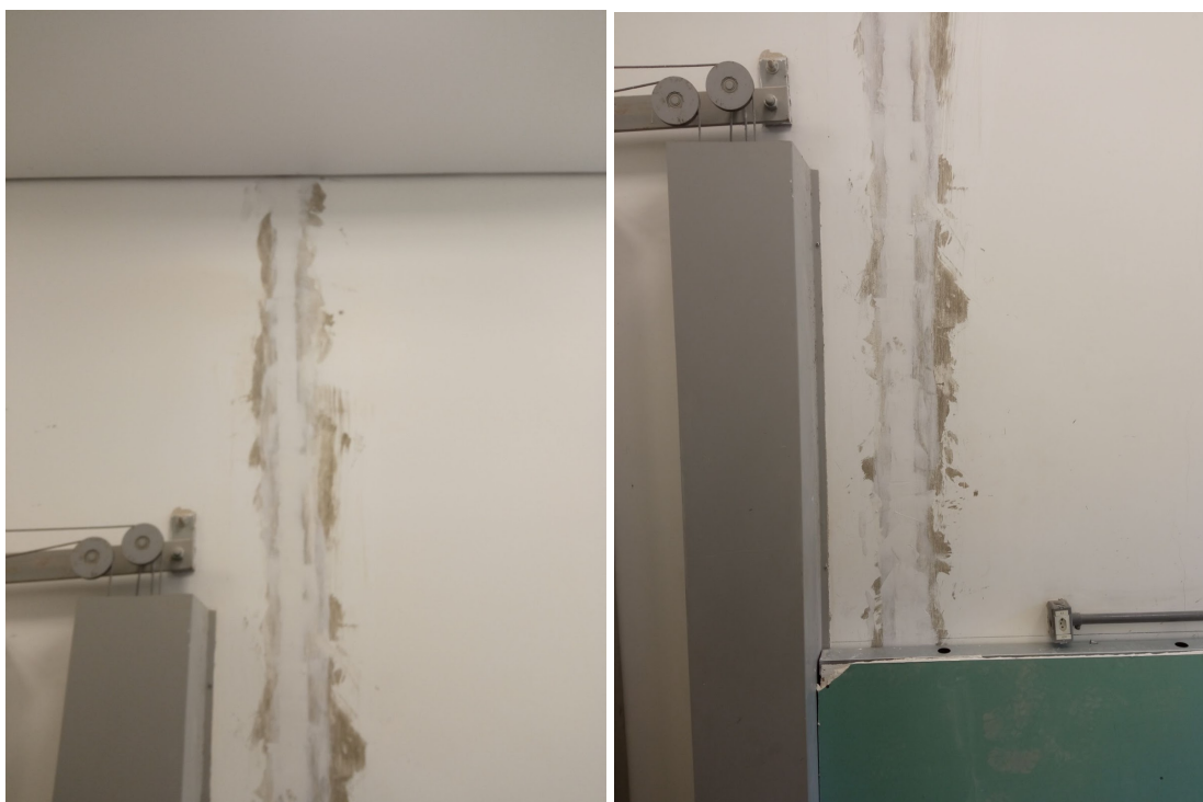
Figura 6 - Rasgo e chumbamento de tubulação de água fria
