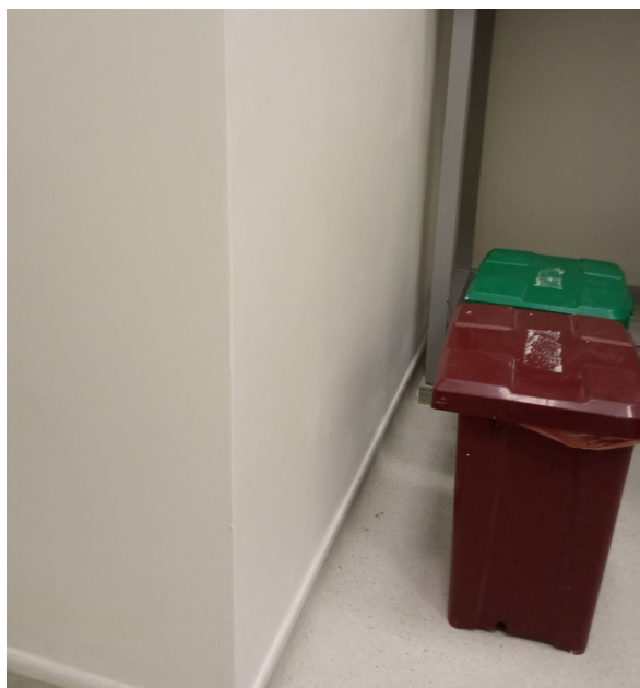
Figura 26 - Reparo aos danos causados na parede da sala 104b, devido ao incidente de 16/08/2024 (finalizado)
