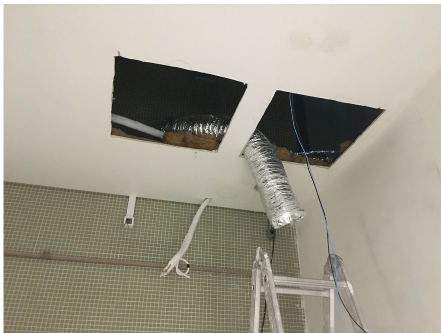
Figura 7 - Abertura de alçapão. Instalação de dutos semiflexíveis de ventilação e exaustão.
