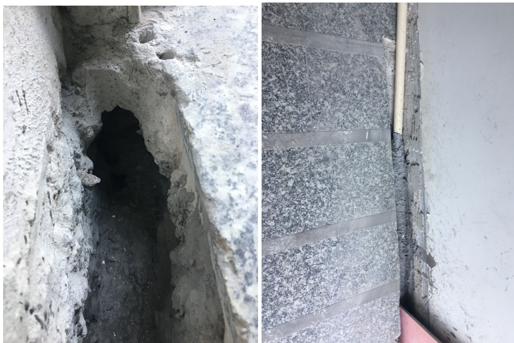
Figura 2 - Demolição de contrapiso, escavação, perfuração de viga de concreto para passagem de tubulação e assentamento de tubulação de esgoto
