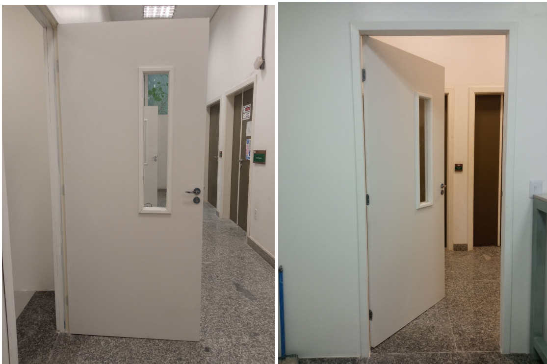
Figura 5 - Instalação de portas
