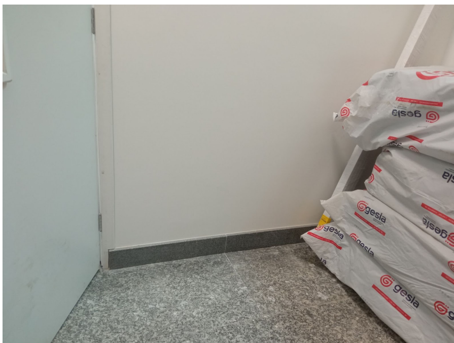
Figura 18 - Instalação de rodapé em granito, fornecido. Emassamento e pintura em parede
