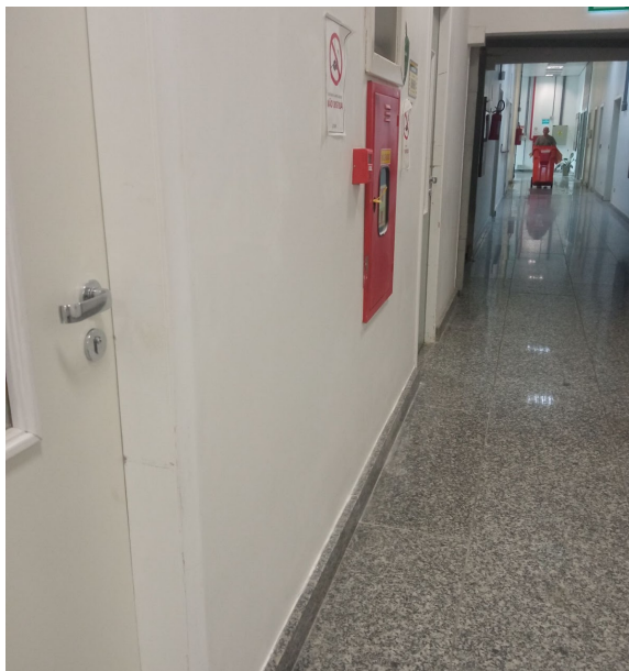
Figura 25 - Reparo aos danos causados na parede do corredor, devido ao incidente de 16/08/2024 (finalizado)
