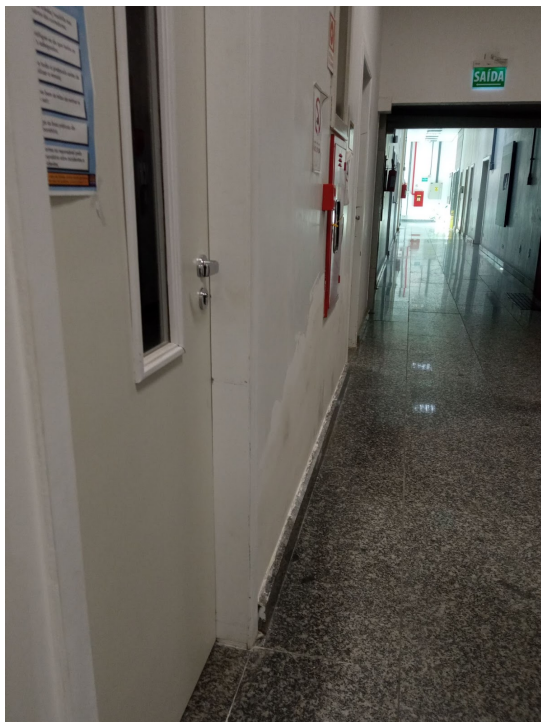
Figura 23 - reparo aos danos causados na parede do corredor, devido ao incidente de 16/08/2024 (em andamento).
