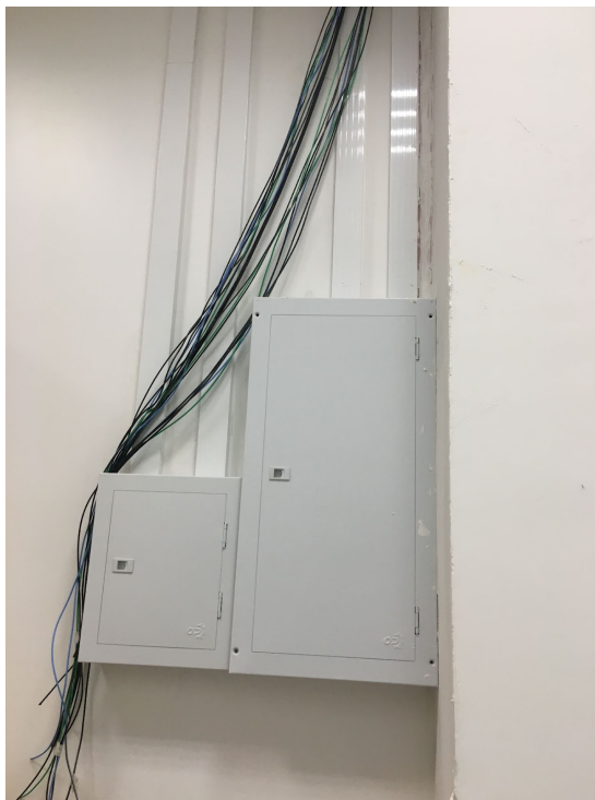
Figura 11 - Instalação de cabos (condutores) elétricos isolados
