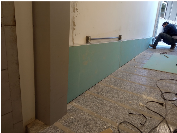
Figura 3 - Fixação de painel de gesso resistente à umidade (gesso verde)
