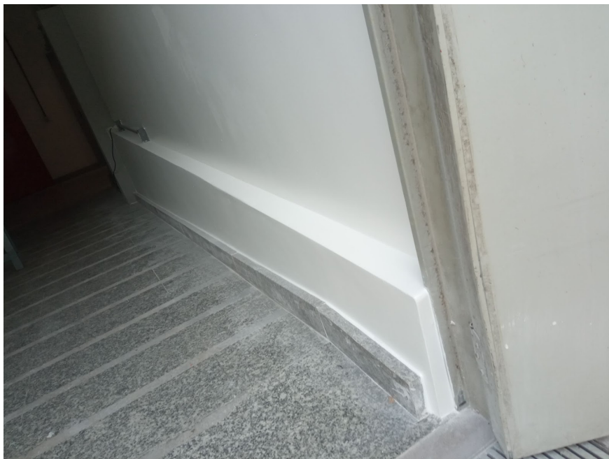
Figura 17 - Instalação de rodapé em granito, aproveitado. Emassamento e pintura em parede.
