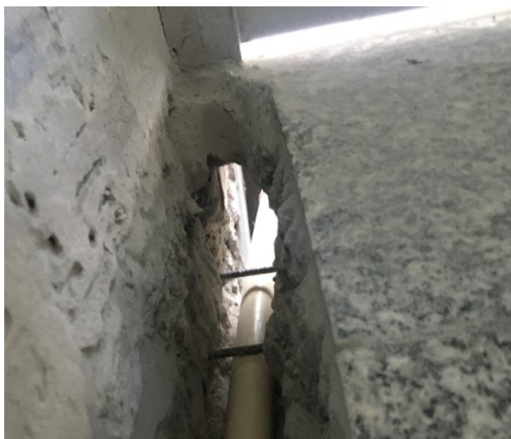
Figura 8 - Furo em concreto para passagem de tubulação.
