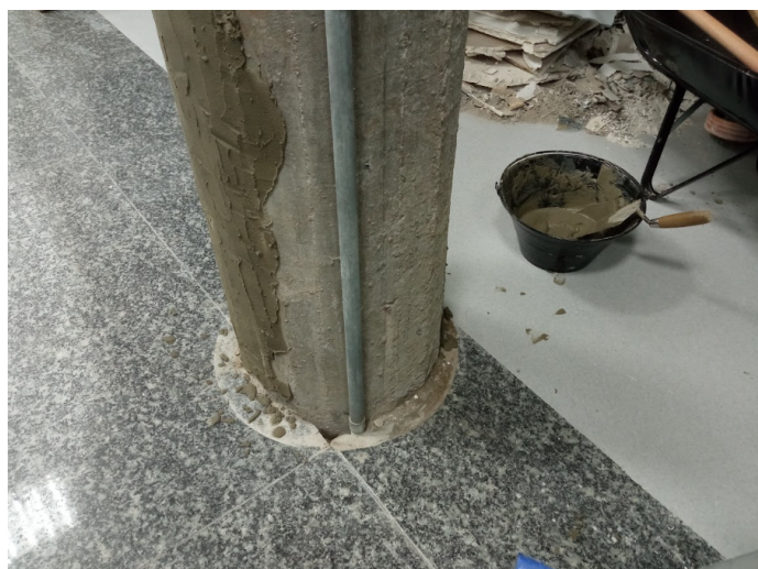
Figura 2 - Demolição de revestimento em ACM.
