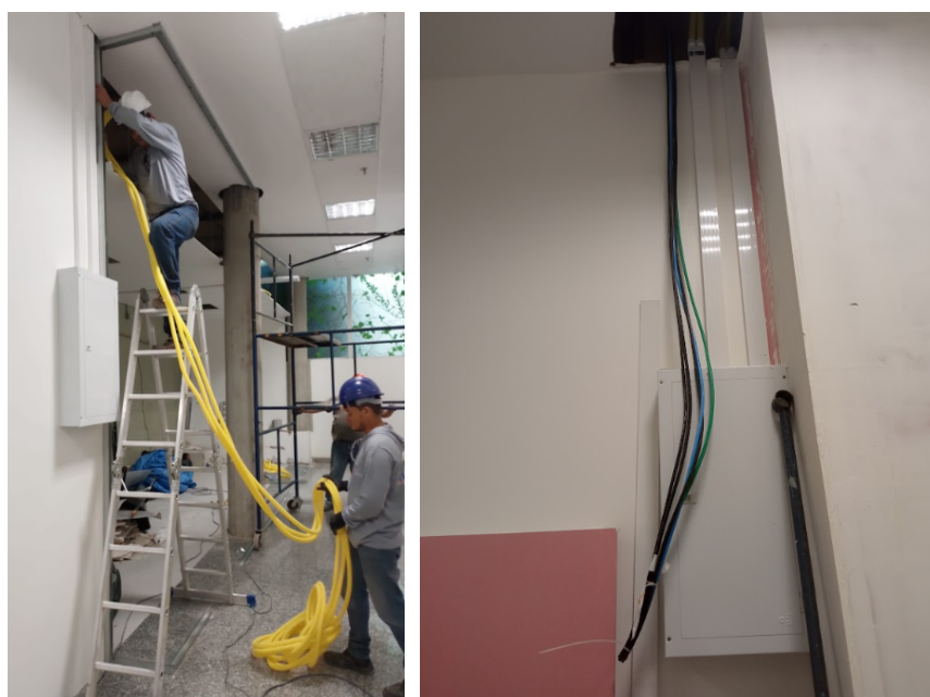
Figura 10 - Instalação de eletrodutos, canaletas, eletrodutos e cabos alimentadores.
