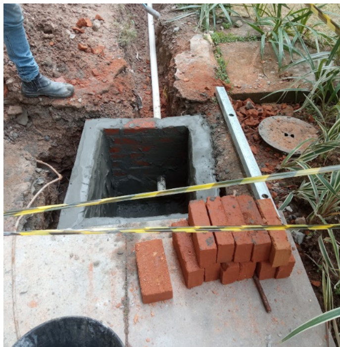
Figura 9 - Construção de caixas enterradas.
