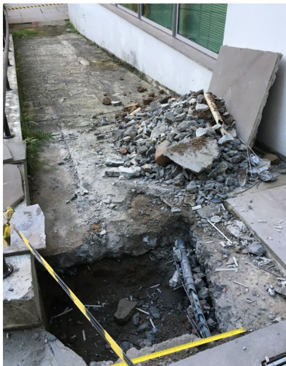
Figura 3 - Escavação manual de vala.
