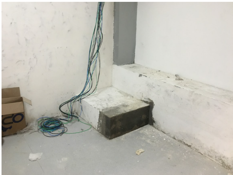
Figura 6 - Aumento da base para compressor
