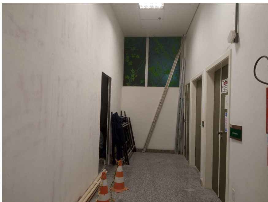
Figura 13 - Preparo de parede com massa PVA e fundo preparador.
