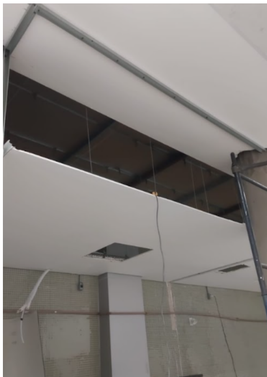
Figura 4 - Remoção de luminárias, interruptores e tomadas.
