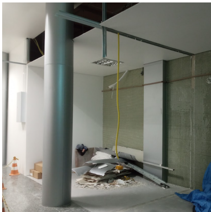
Figura 1 - Demolição de parede de gesso acartonado.
