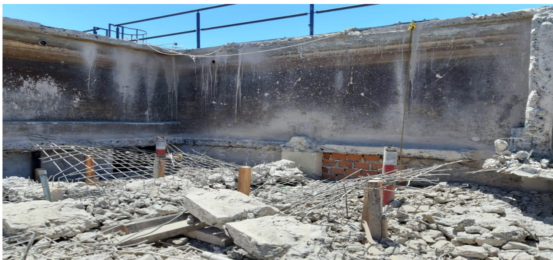
Figura 1 - Demolição do reservatório em concreto armado.
