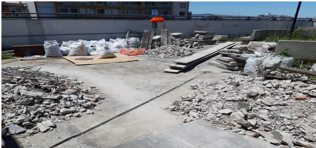
Figura 3 - Entulhos da Demolição do reservatório em concreto armado.
