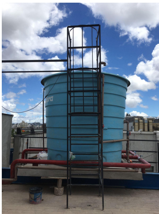
Figura 10 - Fornecimento e instalação de escada marinho.
