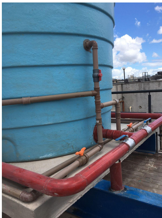
Figura 8 - Remoção de tubulações e instalação de tubos e conexões de consumo de água e de combate a incêndio.
