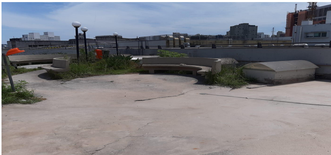
Figura 5 - Limpeza e organização da área da cobertura.
