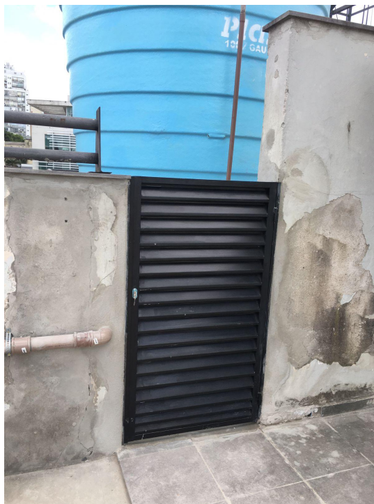
Figura 7 - Fornecimento e instalação de portão de ferro.
