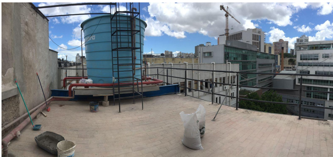
Figura 4 - Limpeza da área do reservatório demolido.
