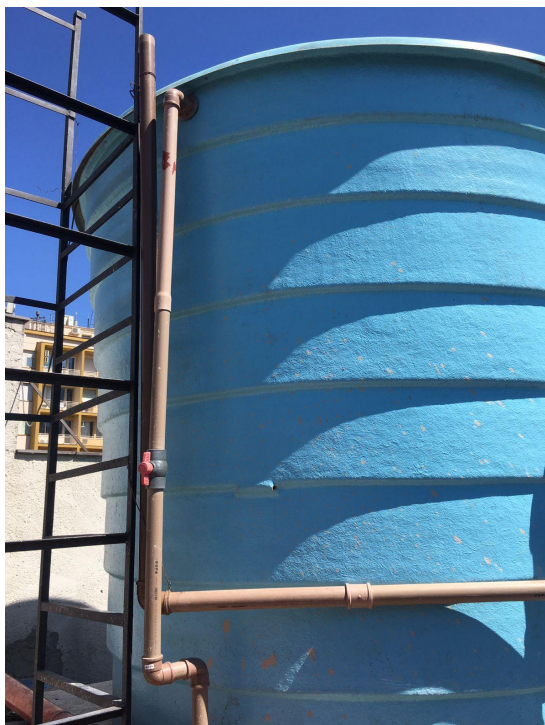
Figura 9 - Instalação de tubos e conexões de ventilação do reservatório.
