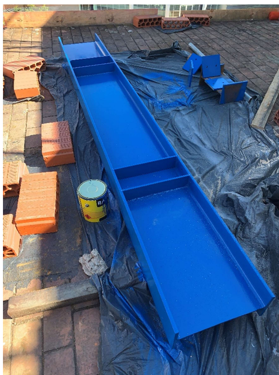
Figura 2 – Pintura de vigas metálicas.
