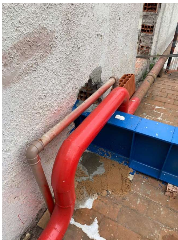
Figura 4 – Fixação de viga.
