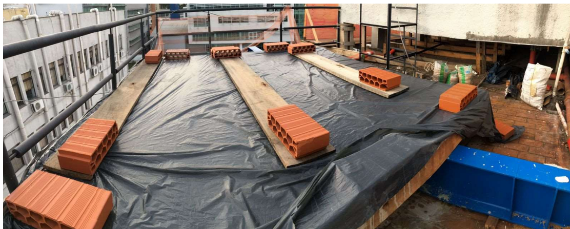
Figura 5 – Concretagem de capa sobre laje pré-moldada.
