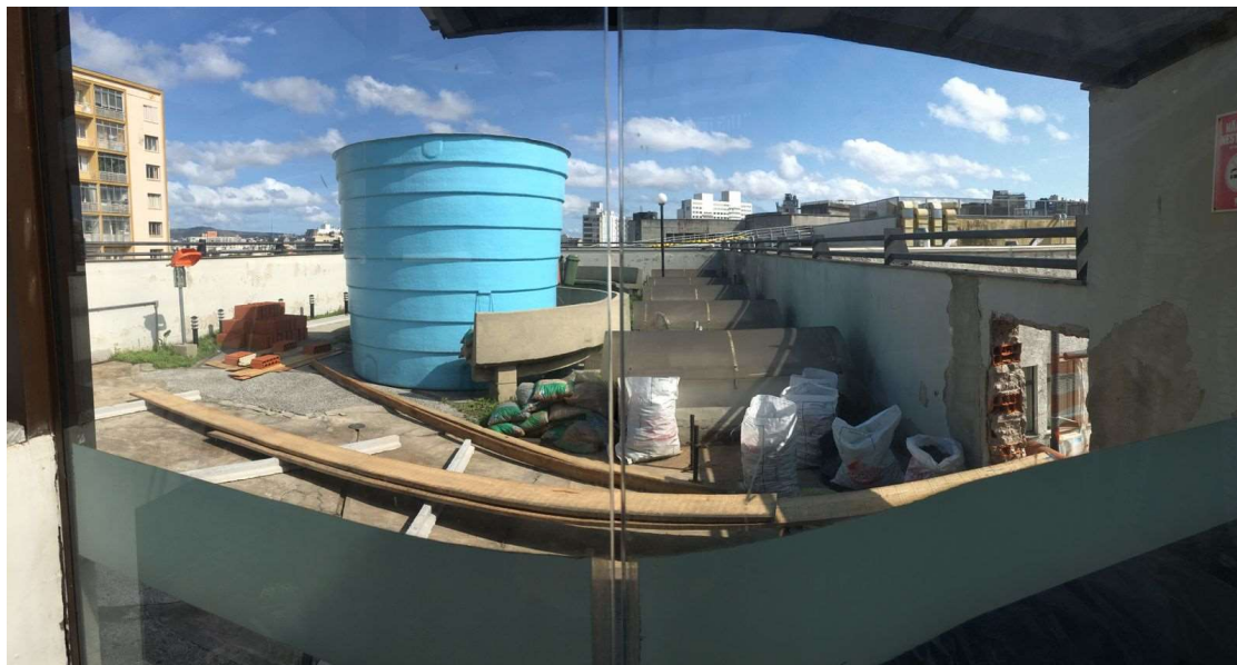
Figura 1 – Material içado e distribuído sobre a laje.
