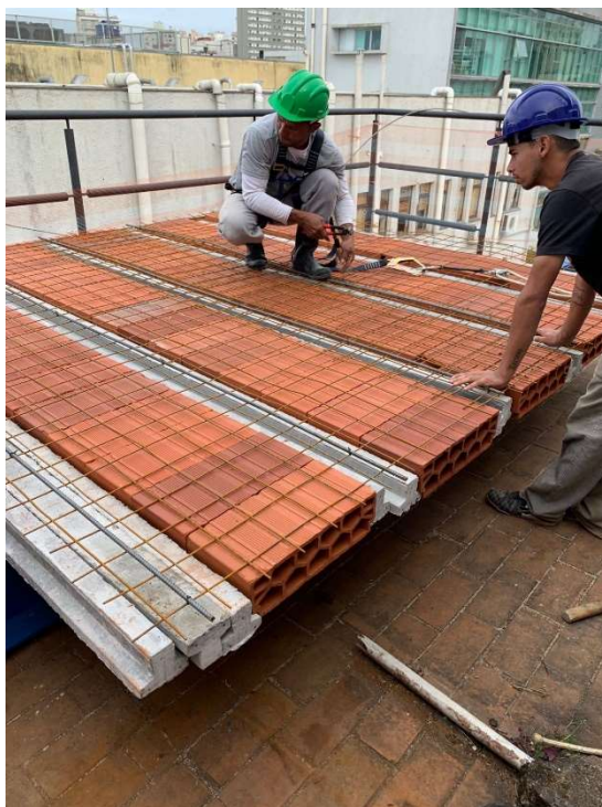
Figura 3 – Montagem da laje pré-moldada.
