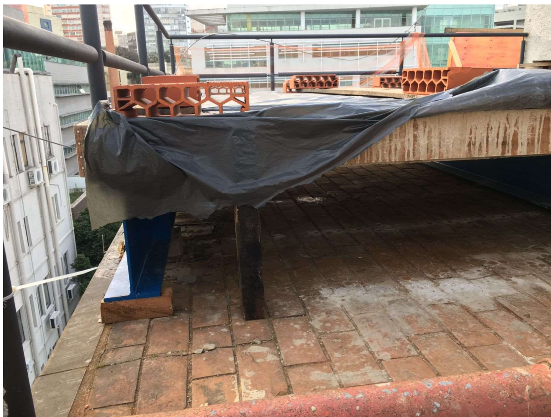
Figura 6 – Fixação das vigas sobre a cabeça dos pilares existentes, conforme projeto estrutural.
