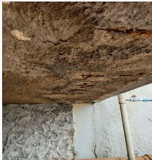
Imagens 06 e 07 – Carbonatação do concreto da laje de fundo do reservatório e exposição das armaduras.
