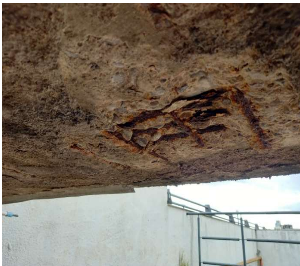
Imagens 06 e 07 – Carbonatação do concreto da laje de fundo do reservatório e exposição das armaduras.
