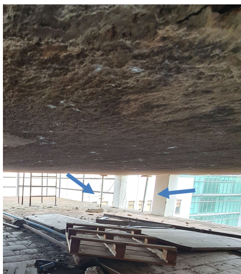
Imagem 14 – Ancoragem no entorno do pilar.
