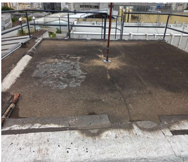
Imagem 02 – Laje de cobertura do reservatório.
