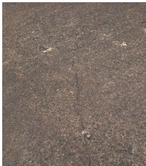
Imagem 03 – Fissura na laje de cobertura.
