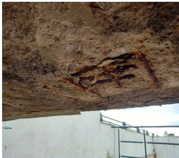
Imagens 06 e 07 – Carbonatação do concreto da laje de fundo do reservatório e exposição das armaduras.
