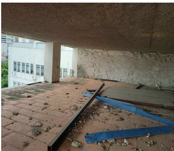
Imagem 04 – Laje do sexto pavimento.
