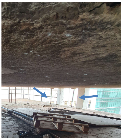
Imagem 14 – Ancoragem no entorno do pilar.
