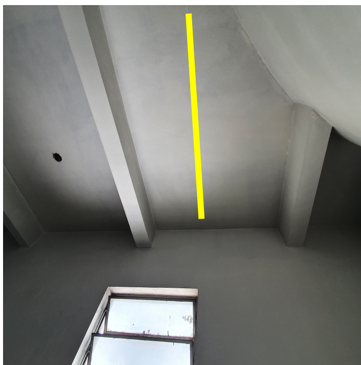
Imagem 01 – Laje da casa de máquinas dos elevadores sociais no 6º pavimento.
