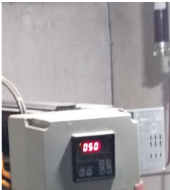
Foto 10 – Sensores de temperatura ativados.
