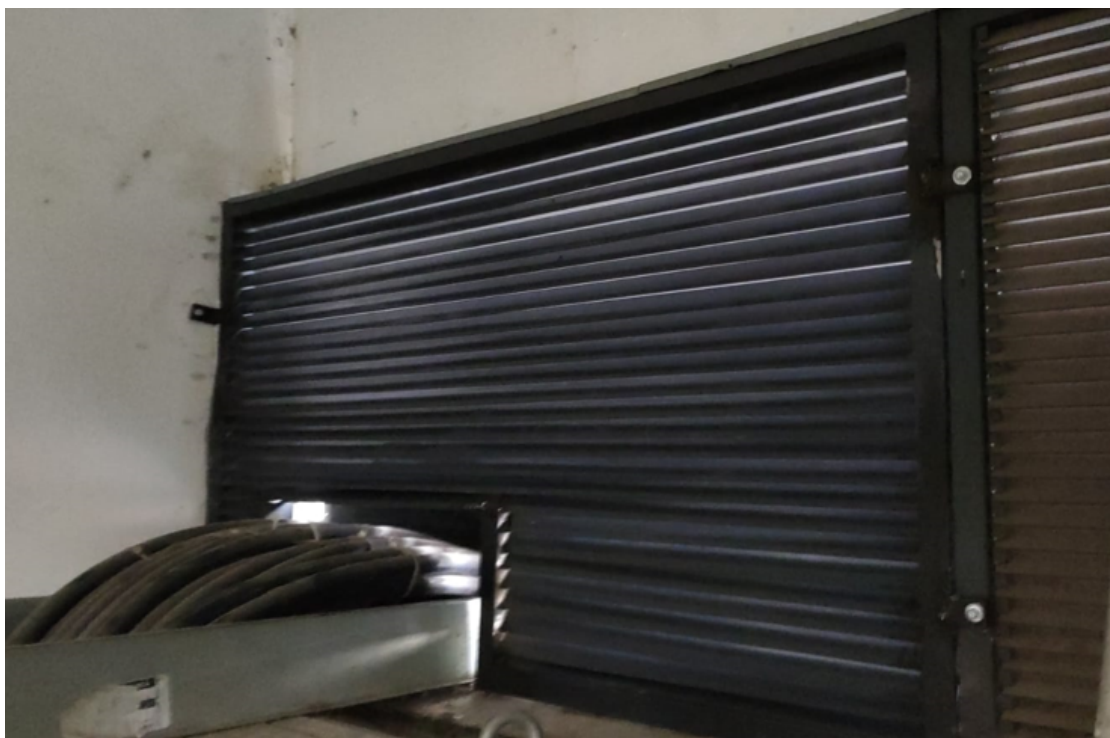
Foto 25 – Janela veneziana metálica.
