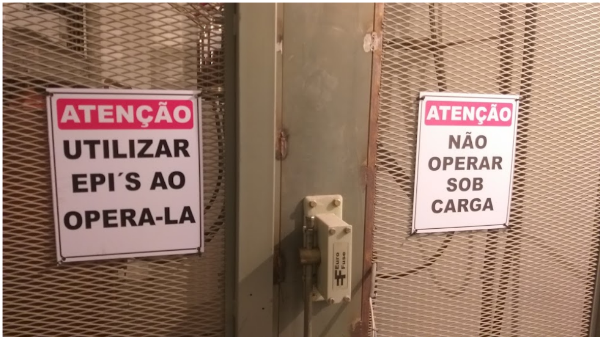
Foto 05 – Novas placas de advertência.
