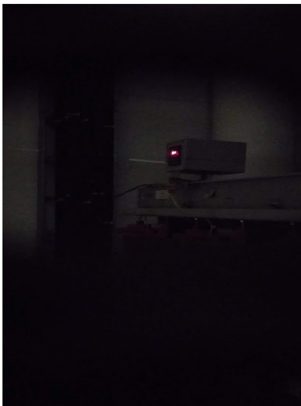
Foto 09 – Sensores de temperatura ativados.
