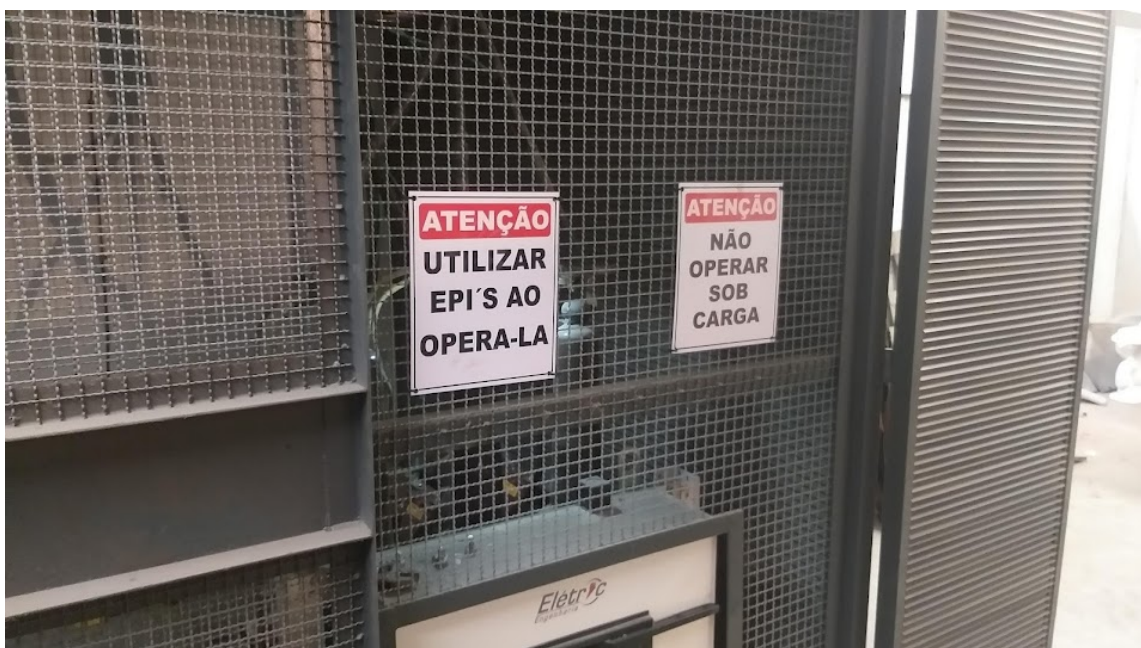
Foto 04 – Novas placas de advertência.
