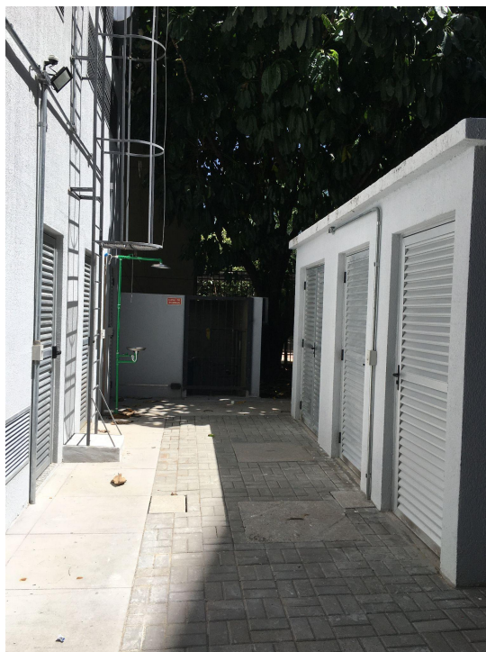
Foto 07 - Piso intertravado com bloco retangular.
