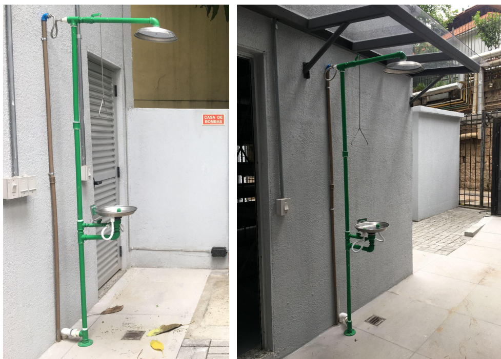
Foto 12 - Instalação de chuveiros e lava-olhos.
