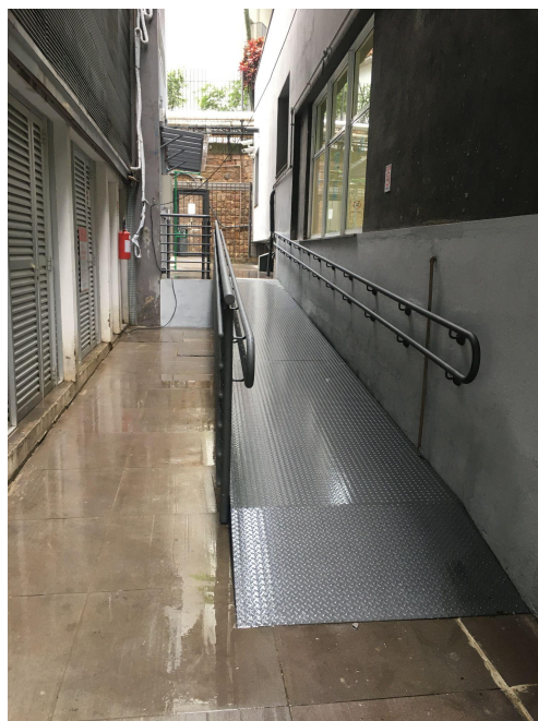
Foto 06 - Conclusão de rampa em estrutura metálica com corrimãos.
