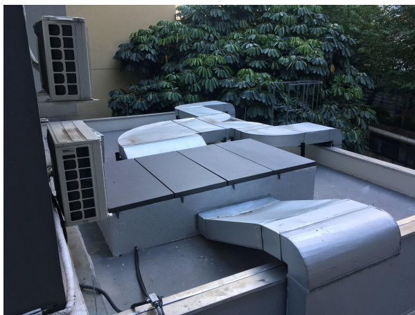
Foto 09 - Conclusão de instalação de dutos e equipamentos de climatização e exaustão.
