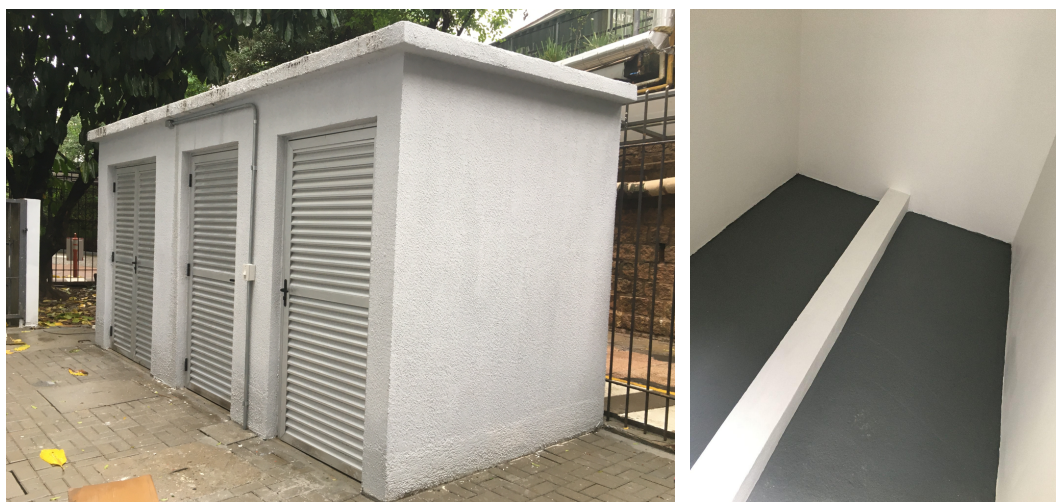
Foto 08 - Pintura de piso e de paredes da casa de resíduos.
