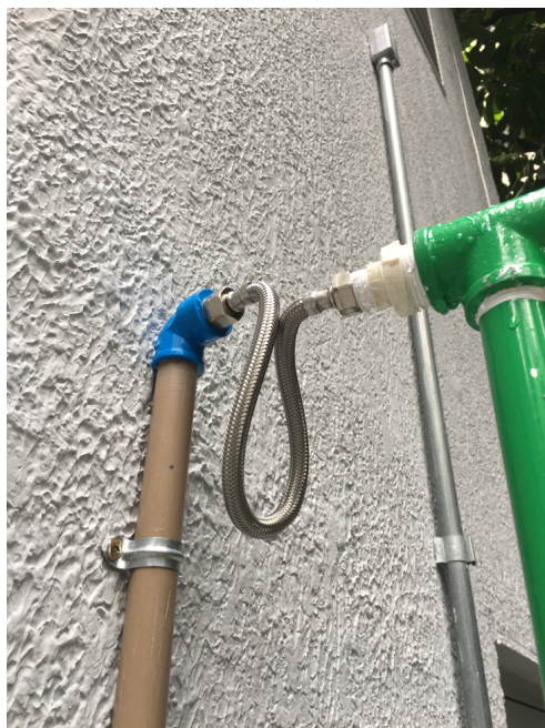
Foto 05 - Engate flexível em inox.
