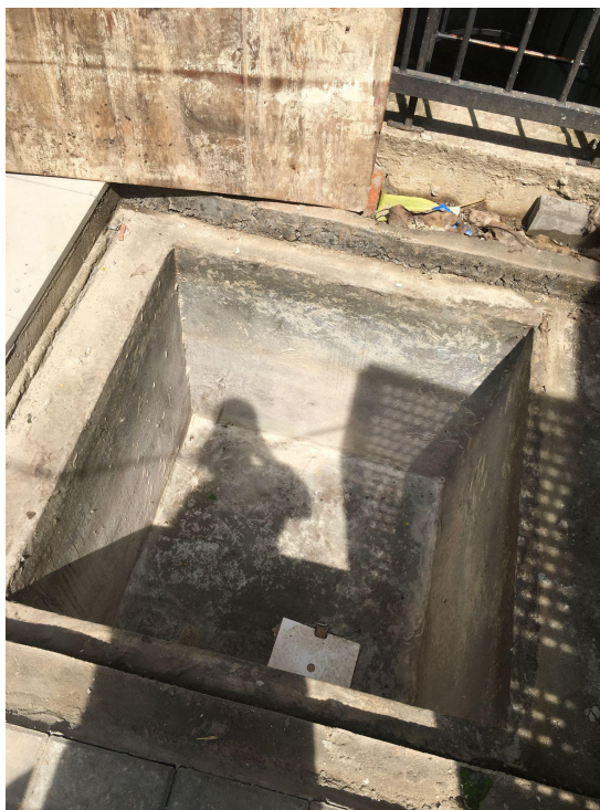
Foto 09 - Impermeabilização de caixa de contenção de resíduos com véu de fibra de vidro.
