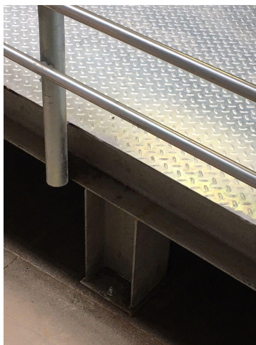
Foto 06 - Pilaretes metálicos para rampa.
