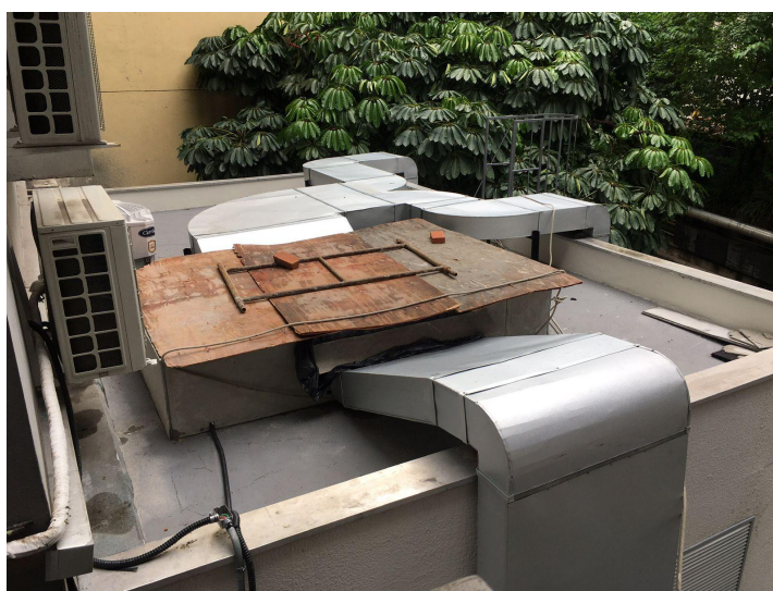
Foto 10 - Instalação de dutos e equipamentos para climatização.
