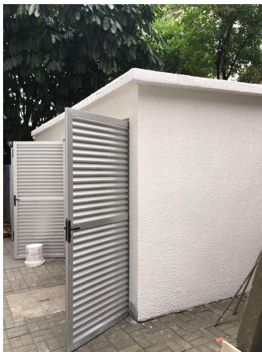
Foto 03 - Portas em alumínio venezianas para a casa de resíduos.
