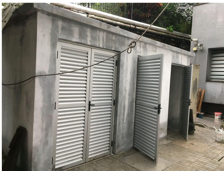
Foto 01 - Construção de casa para resíduos.
