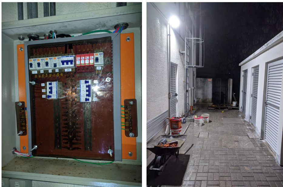
Foto 11 - Instalação de cabo de cobre flexível, interruptores bipolares, disjuntores unipolares, eletrodutos metálicos rígidos, refletor slim led, rele fotoelétrico.
