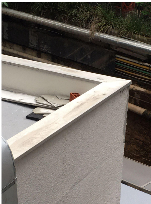
Foto 05 - Instalação de rufo metálico.
