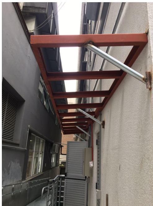
Foto 02 - Estrutura para cobertura de policarbonato.
