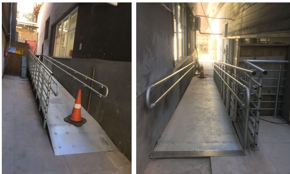
Foto 03 - Instalação de rampa em estrutura metálica com guarda-corpo.
