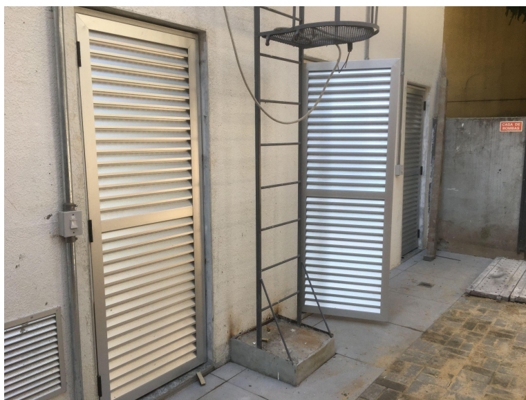
Foto 01 - Instalação de portas de alumínio venezianas.
