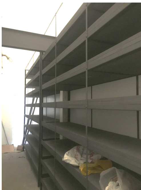
Foto 02 - Instalação de estante de armazenamento de produtos químicos.
