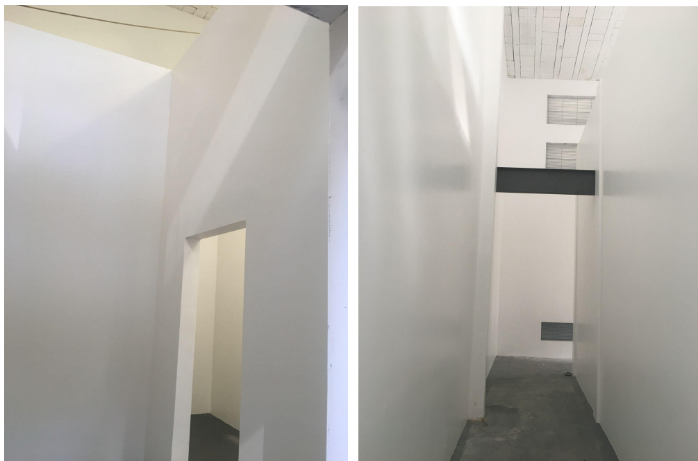
Foto 05 - Pintura acrílica em paredes.
