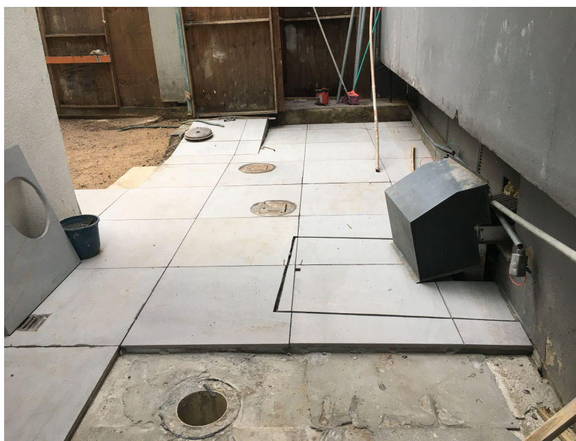
Foto 04 - Execução de contrapiso em argamassa e instalação de piso em basalto.
