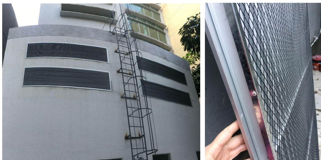
Foto 02 - Instalação de esquadria tipo veneziana em alumínio com tela.
