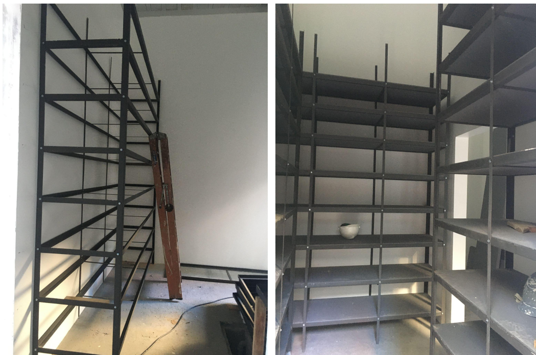
Foto 03 - Instalação de estante de armazenamento de produtos químicos.
