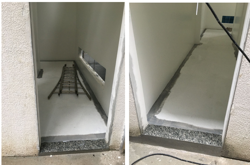
Foto 03 - Instalação de soleira em granito.
