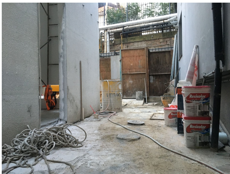
Foto 02 - Demolição de piso em basalto.
