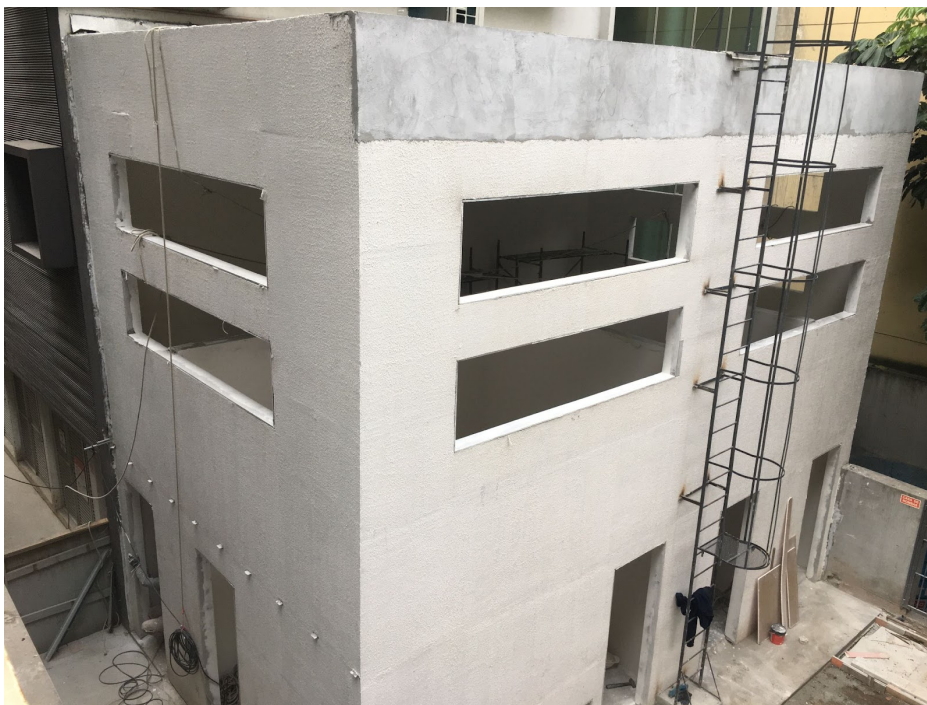
Foto 07 - Pintura com selador em paredes.
