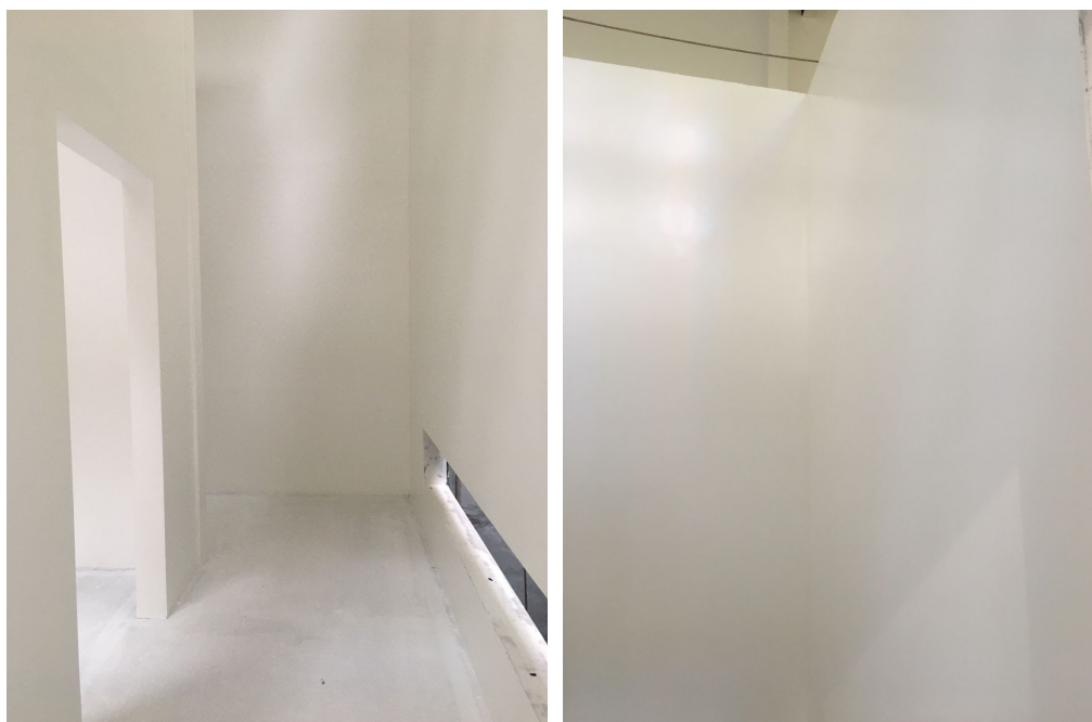
Foto 06 - Pintura acrílica em paredes.
