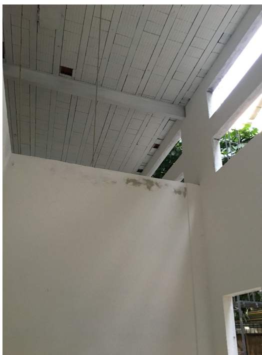
Foto 04 - Aplicação manual de massa corrida e lixamento em paredes.
