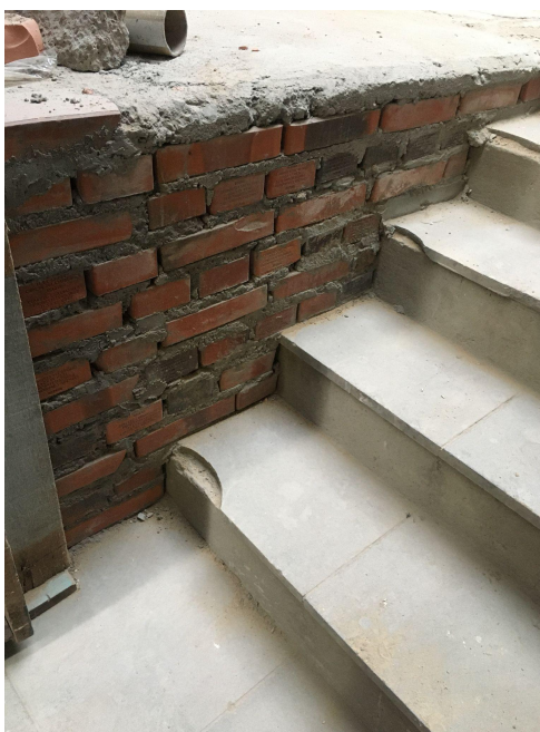
Foto 04 - Alvenaria estrutural para patamar.
