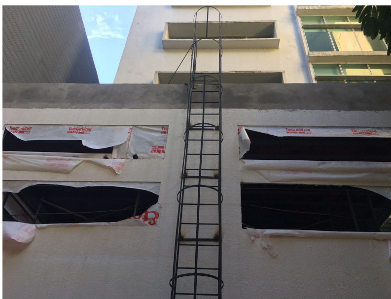
Foto 02 - Retirada e reinstalação de escada marinheiro.
