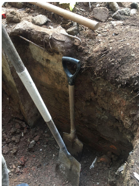
Foto 03 - Escavação manual de vala.
