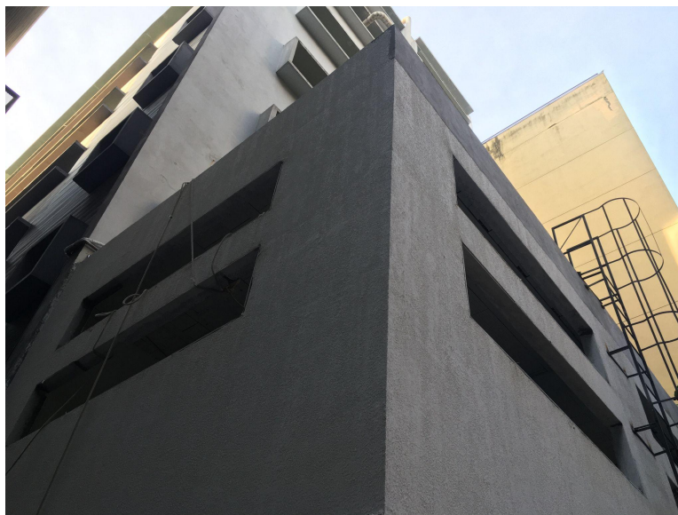
Foto 11 - Pintura com selador em paredes.
