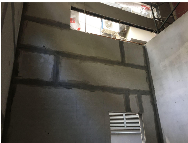
Foto 06 - Paredes em placa cimentícia dupla.
