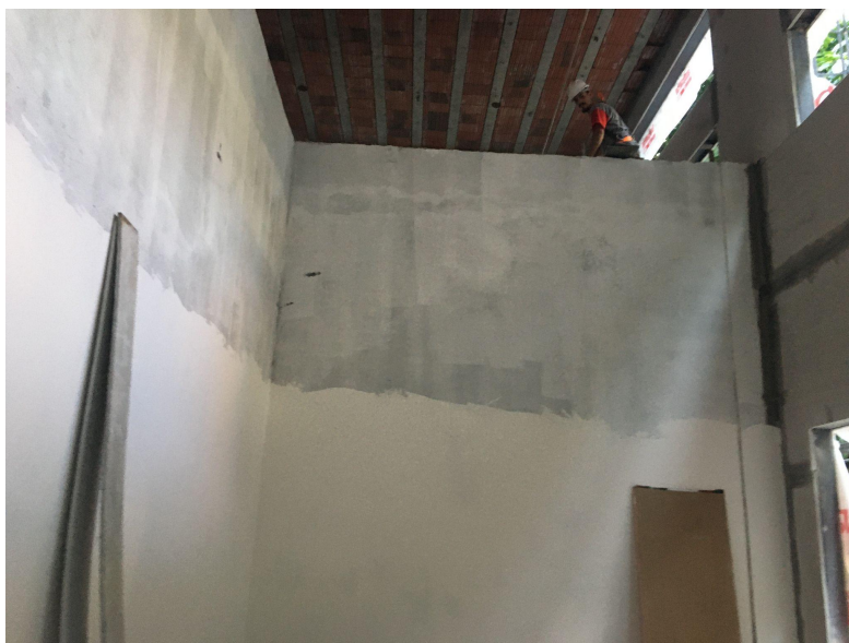
Foto 10 - Aplicação manual de massa corrida e massa acrílica em paredes.
