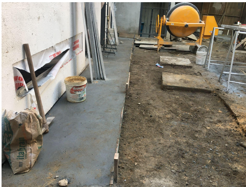
Foto 09 - Contrapiso em argamassa.
