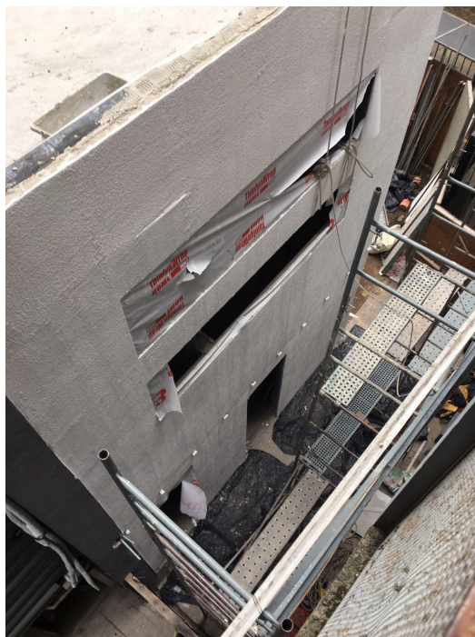
Foto 03 - Paredes em placa cimentícia dupla.
