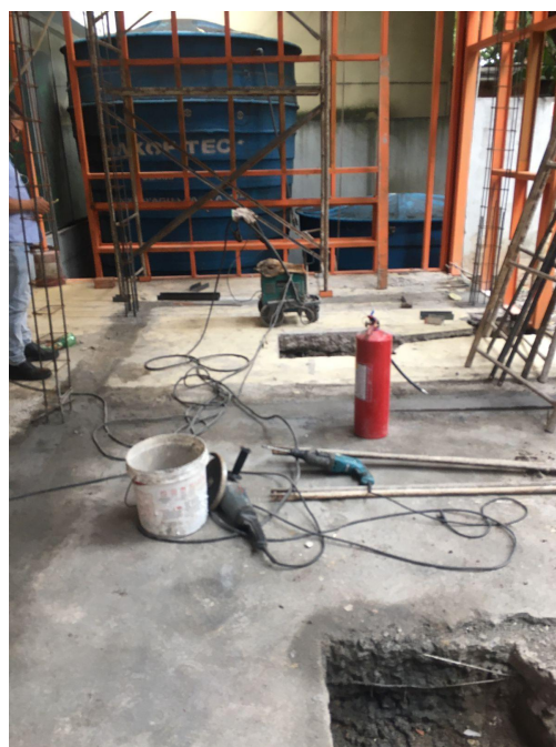
Foto 10 - Vigas baldrame para paredes.
