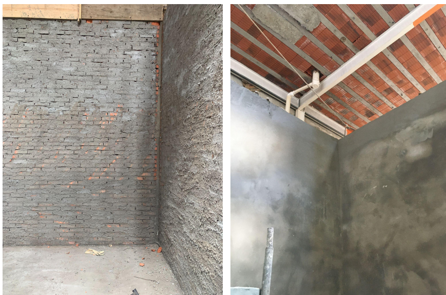
Foto 06 - Chapisco e massa única em alvenaria.
