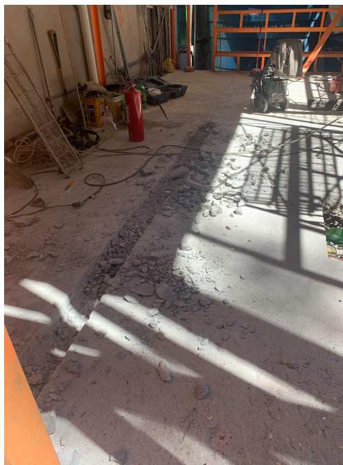
Foto 09 - Rasgo em contrapiso para paredes.
