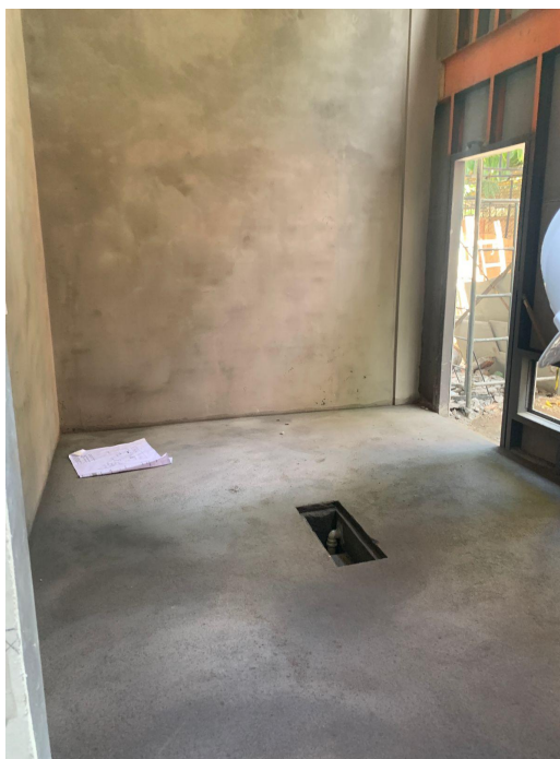
Foto 01 - Piso cimentado natado com argamassa.
