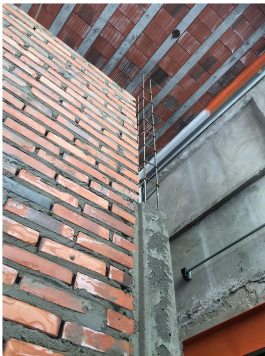
Foto 05 - Pilares em concreto armado.
