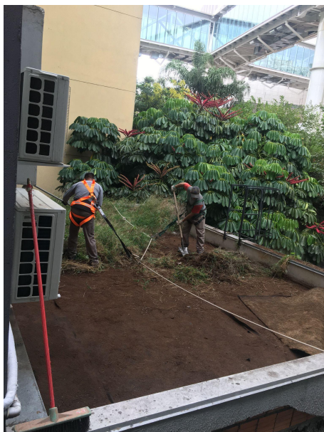
Foto 02 – Limpeza da laje da cobertura.
