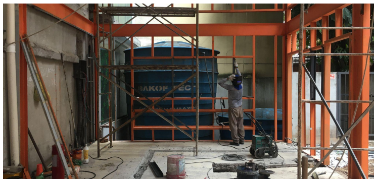
Foto 05 – Reforço da estrutura metálica.
