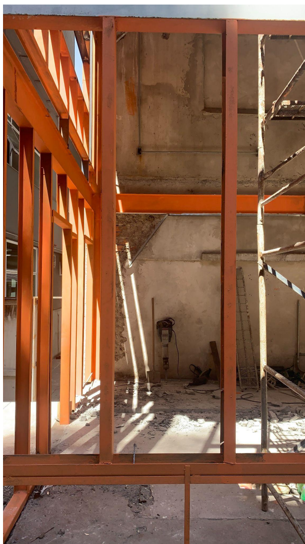
Foto 06 -Pintura com fundo anti corrosivo das estruturas metálicas.
