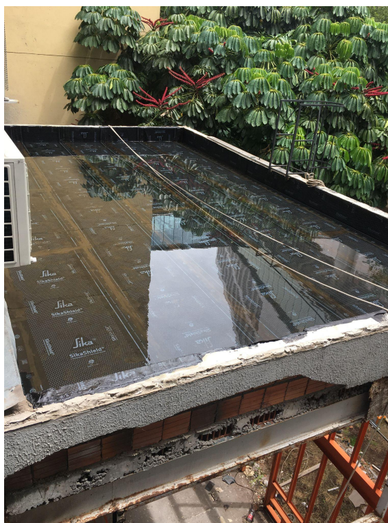
Foto 04 – Teste de estanqueidade após aplicação de manta de impermeabilização.
