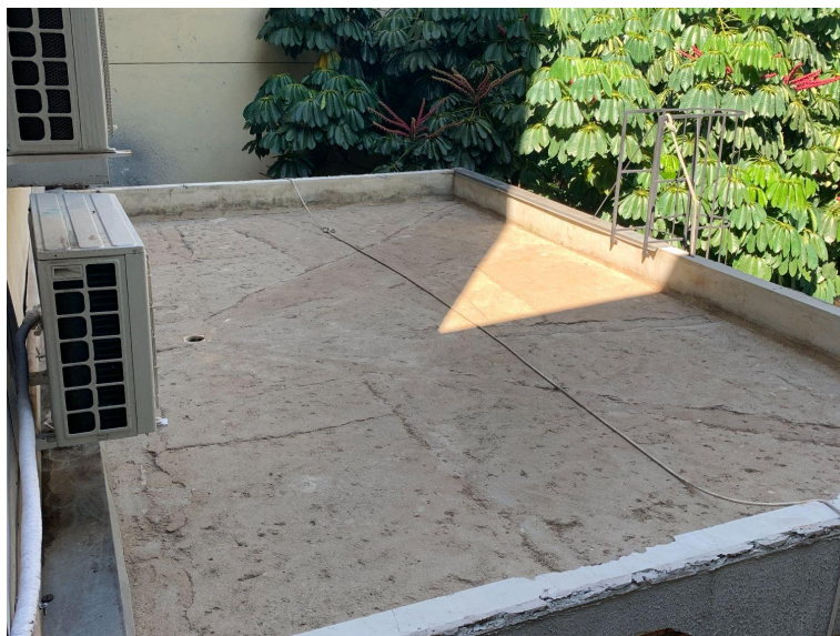
Foto 03 – Execução da camada de regularização.
