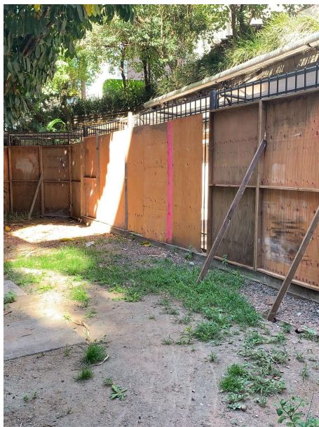
Foto 01 – Execução de tapumes.
