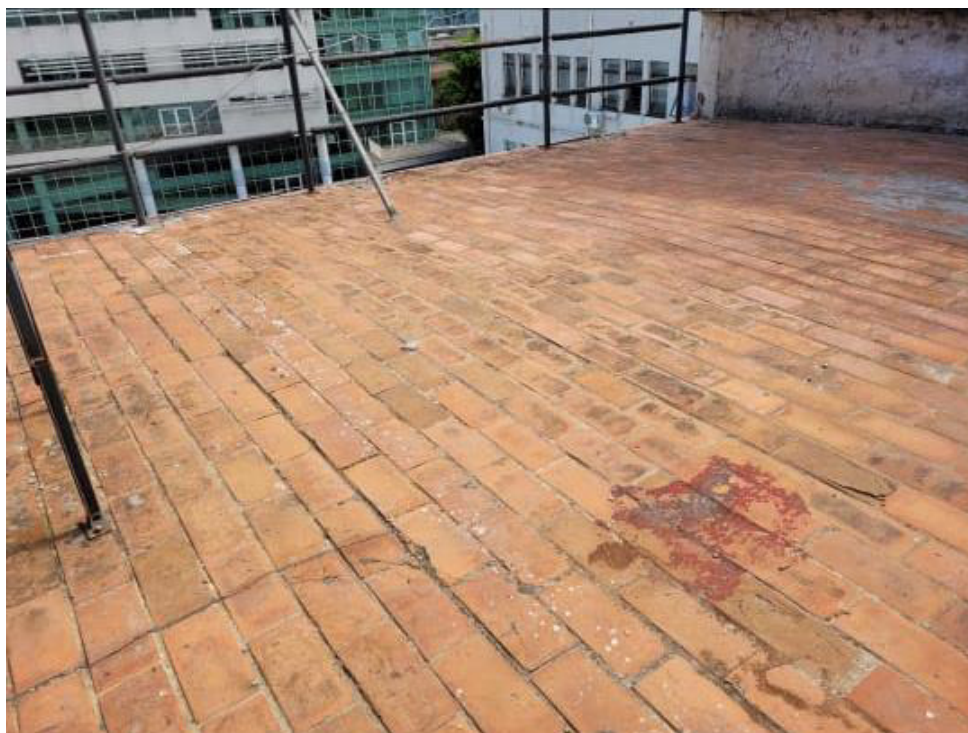
Foto 1 – Camada de proteção em tijolo maciço
