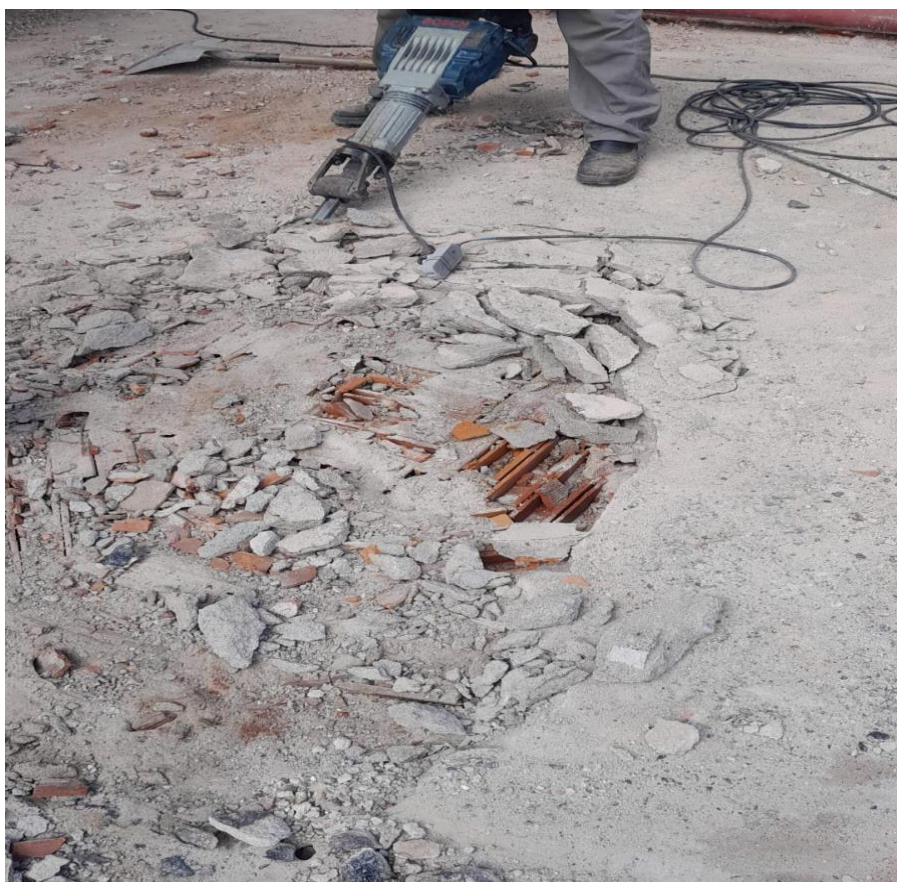
Foto 4 – Camada de proteção removida no centro da laje
