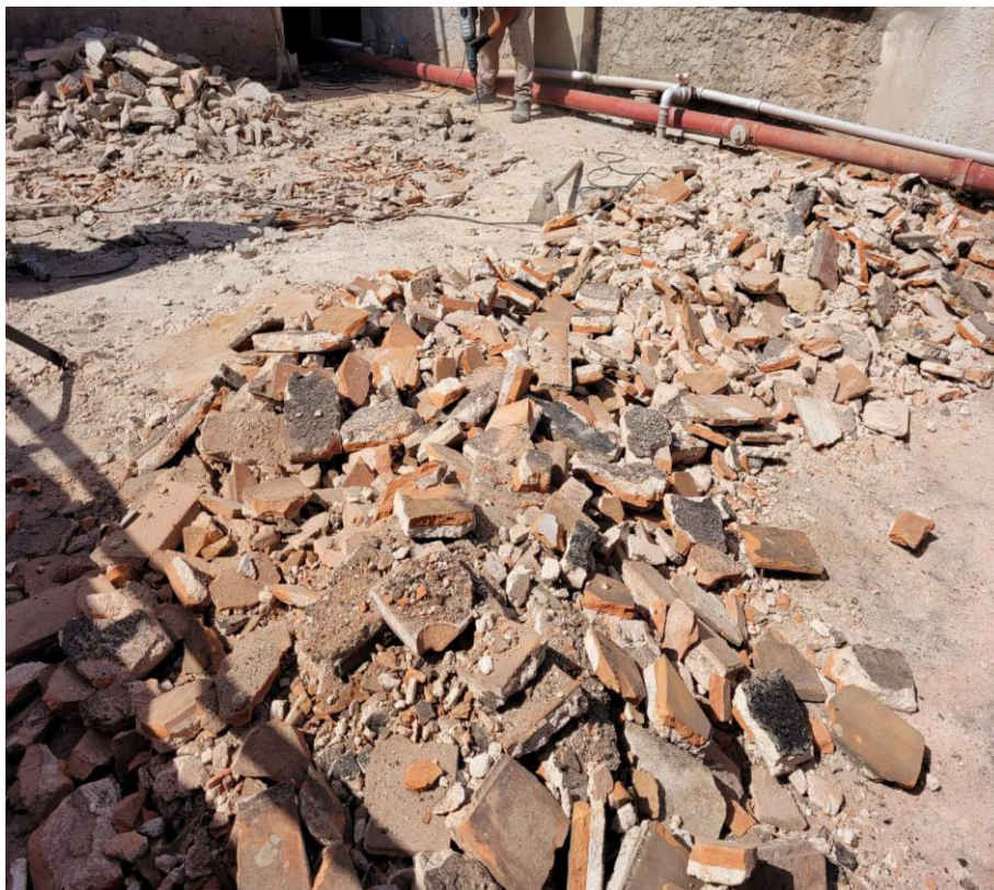
Foto 3 – Camada de proteção removida
