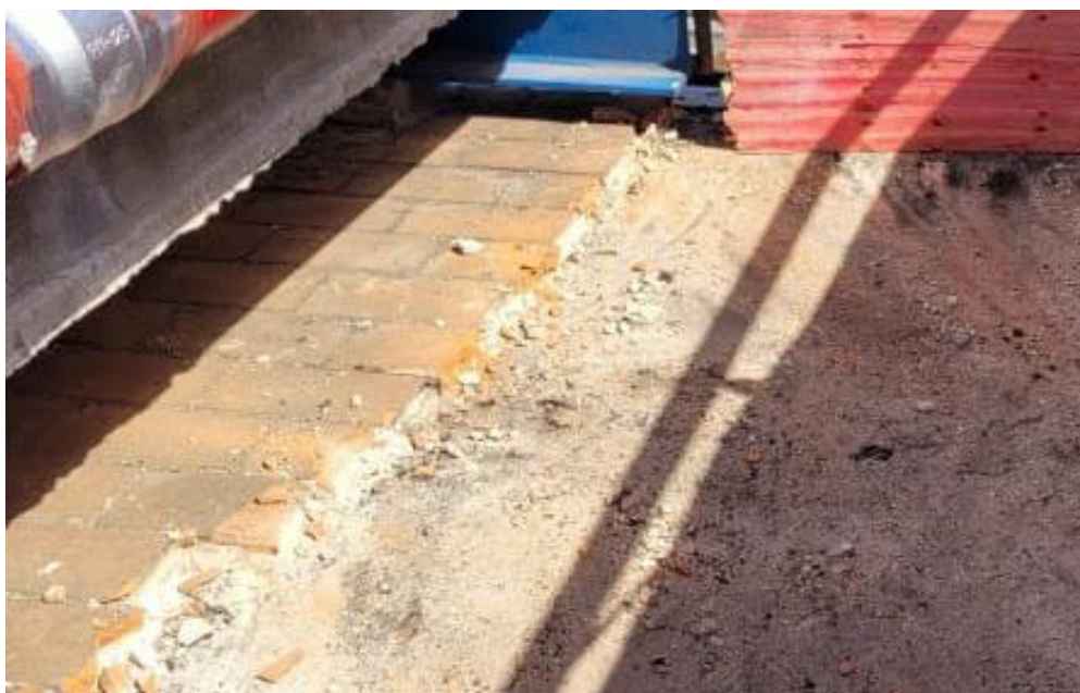
Foto 2 - Camada de proteção removida
