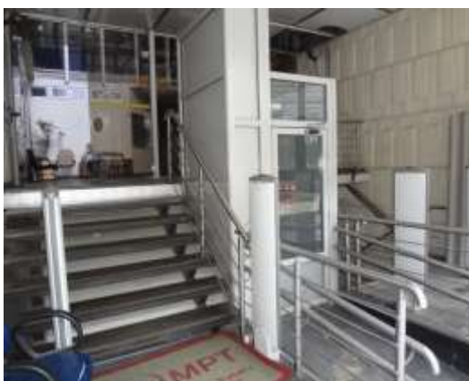
Foto 3 – Acesso ao pavimento térreo
