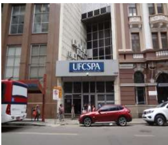
Foto 1 - Vista externa do imóvel - Fachada
