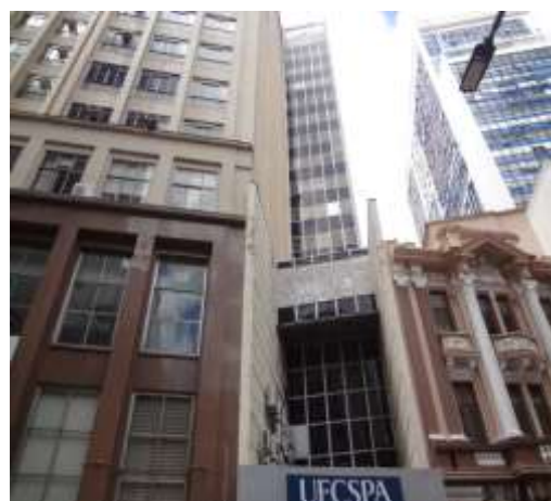
Foto 2 - Vista externa do imóvel - Fachada
