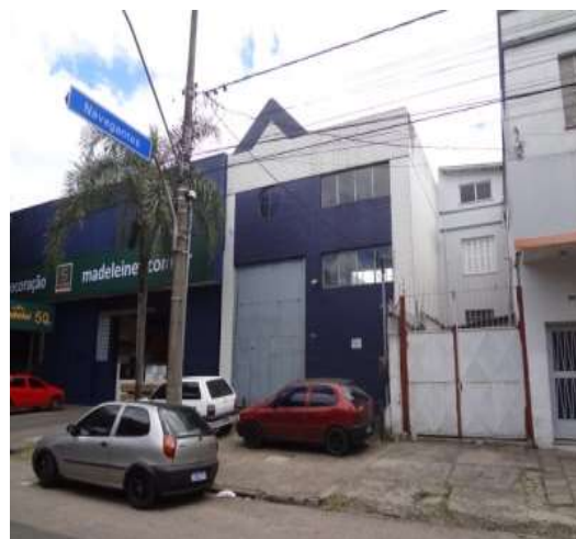
Foto 2 – Fachada pela Rua Arbutan nº 790
