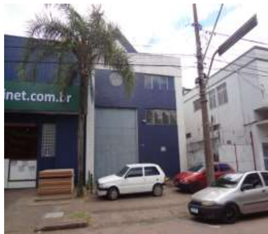
Foto 2 – Fachada pela Rua Arbutan nº 790
