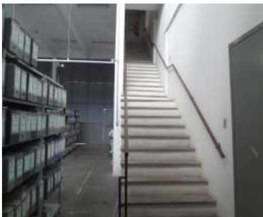
Foto 5 – Acesso ao mezanino
