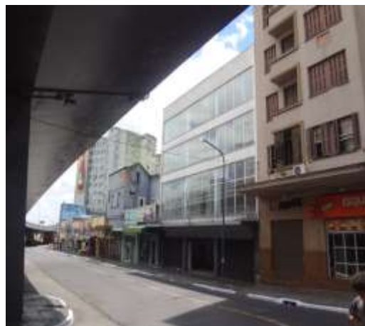
Foto 2 - Vista externa do imóvel - Fachada
