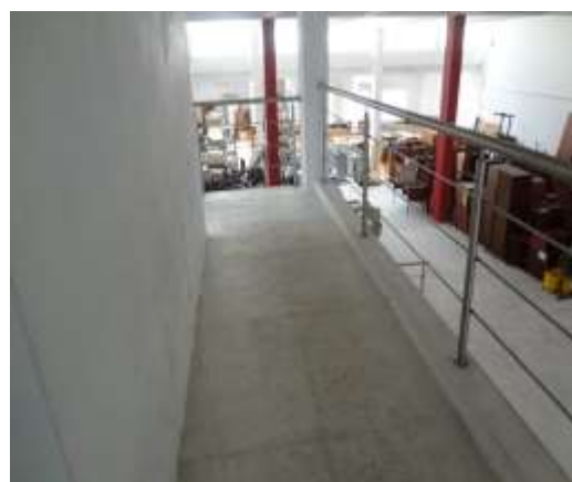
Foto 6 – 2º Pavimento - Mezanino
