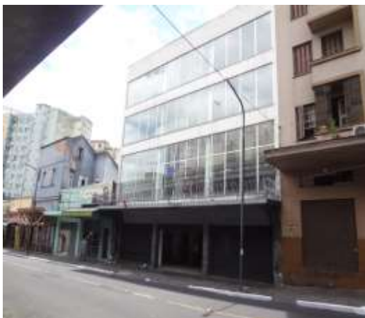
Foto 1 - Vista externa do imóvel - Fachada
