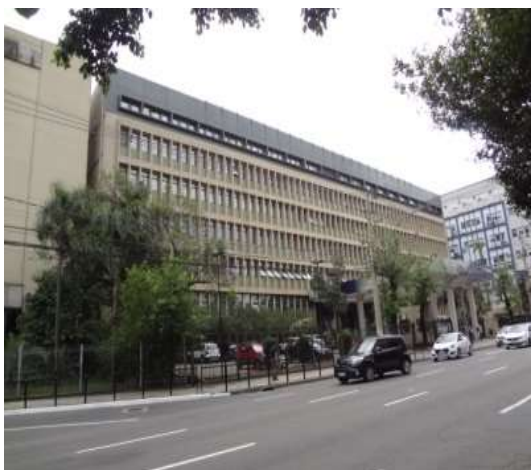
Foto 1 - Fachada do Prédio 1
