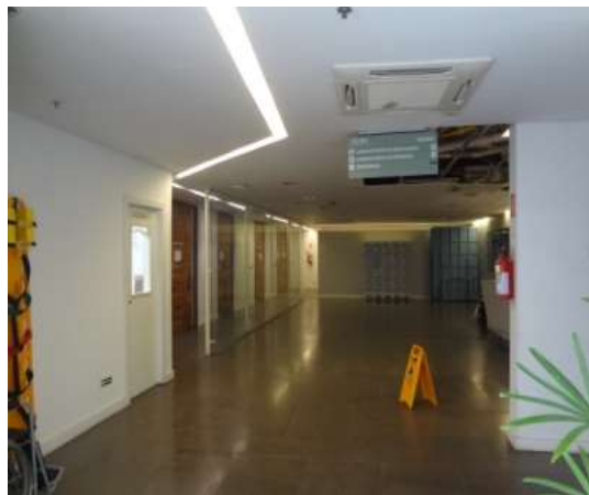
Foto 8 – Circulações internas do Prédio 2
