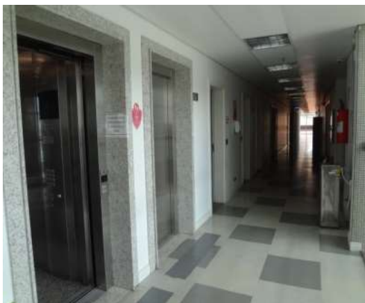
Foto 11 - Circulações internas do Prédio 3
