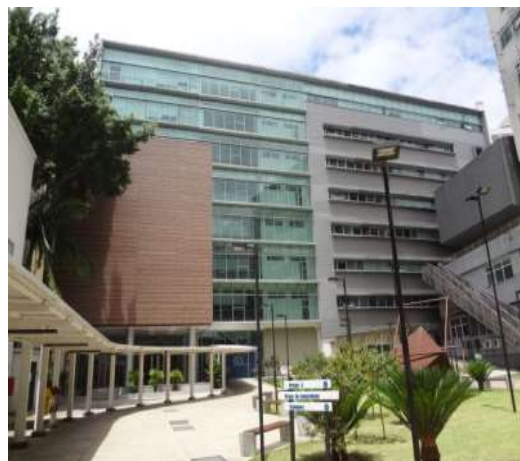
Foto 10 - Fachada do Prédio 3
