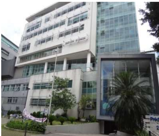
Foto 7 – Fachada do Prédio 2
