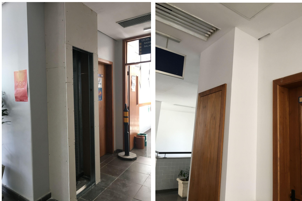
Foto 03 – Construção de shafts em gesso acartonado.
