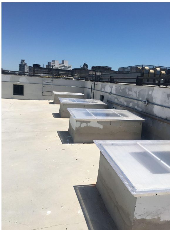
Foto 04 – Instalação de coberturas em claraboias.
