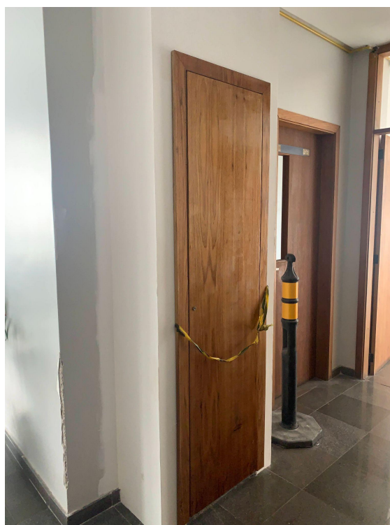
Foto 06 – Instalação de portas em madeira nos shafts de gesso acartonado.
