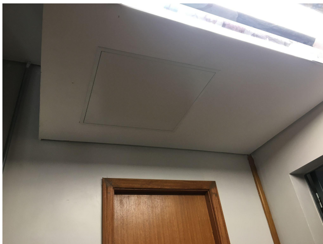
Foto 09 – Instalação de alçapões.
