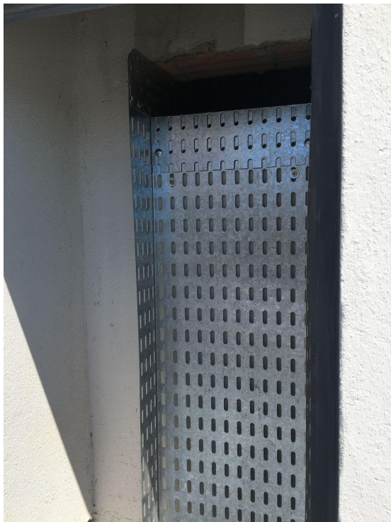
Foto 14 - Instalação de eletrocalha em shaft.
