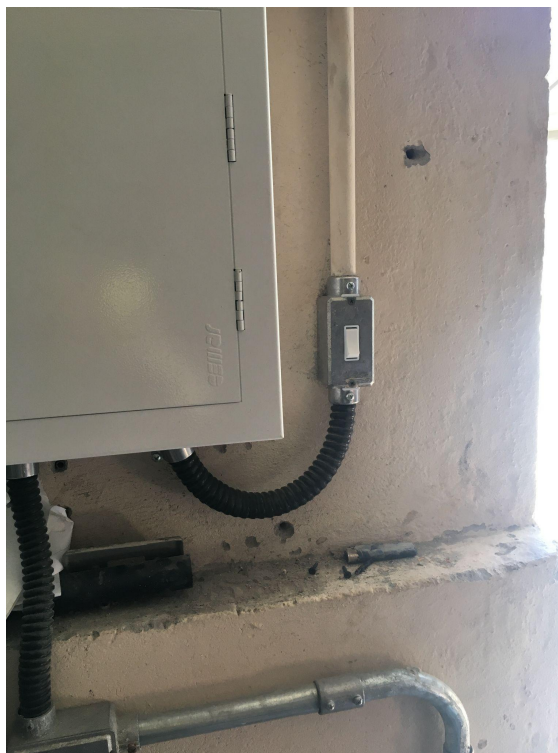
Foto 12 - Instalação de interruptor na casa de máquinas.
