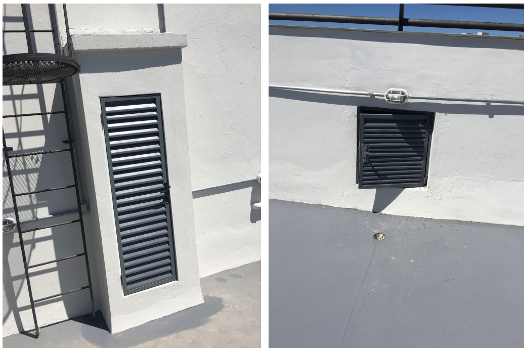
Foto 05 – Instalação de portas em aço.
