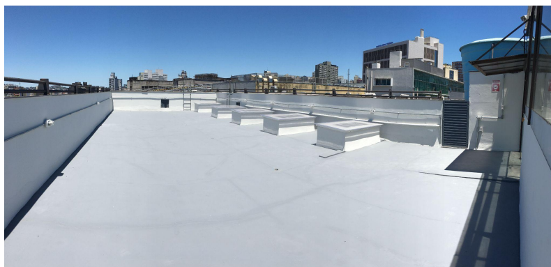
Foto 10 – Execução de pintura em piso.
