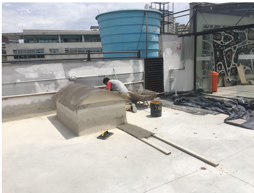
Foto 01 – Remoção de revestimento das muretas da cobertura.
