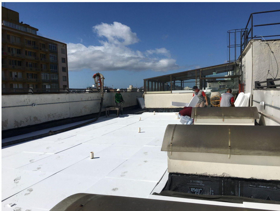
Foto 07 – Instalação de isolamento em isopor.
