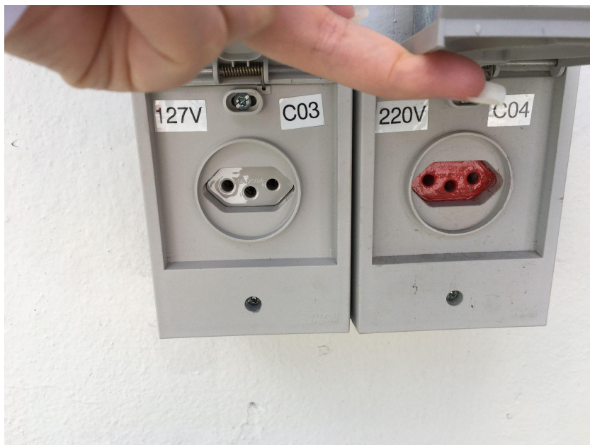
Foto 13 - Instalação de tomadas à prova d'água.
