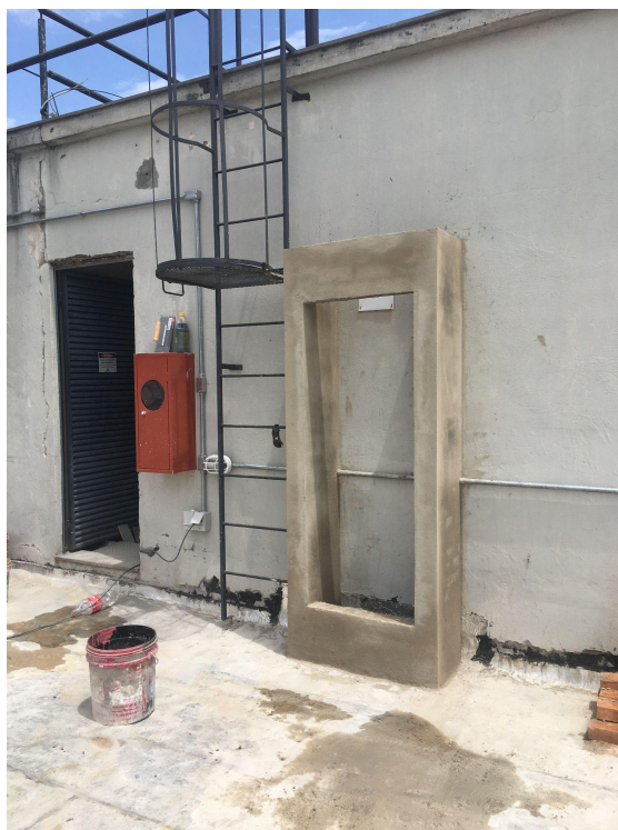
Foto 02 – Construção de shaft em alvenaria.
