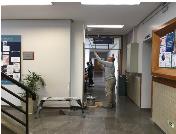
Foto 11 – Execução de pintura em paredes.
