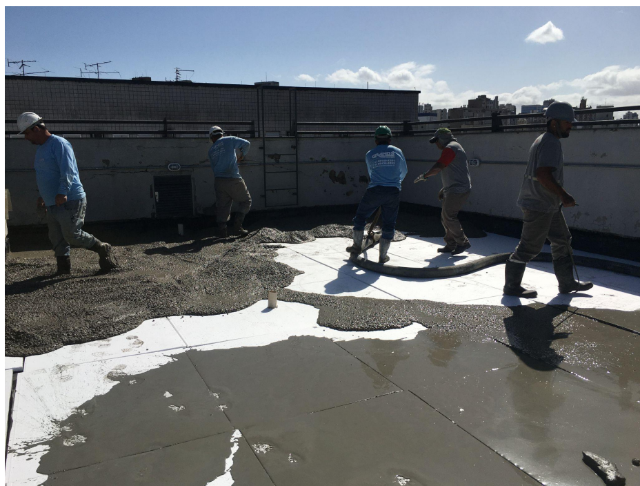
Foto 08 – Execução de concretagem.
