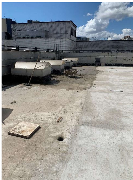
Foto 04 – Execução de camada de regularização.
