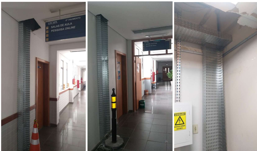
Foto 12 - Instalação de eletrocalhas.
