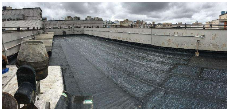
Foto 05 – Execução de primer e manta de impermeabilização.
