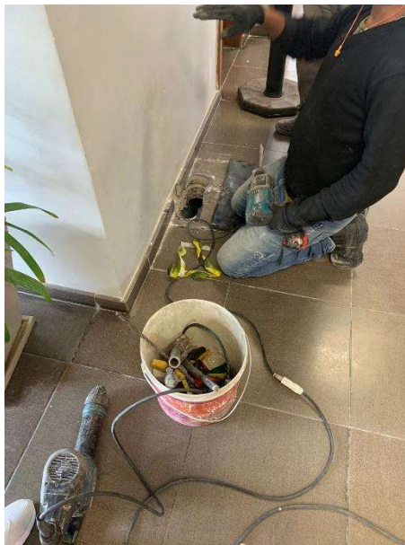
Foto 01 – Execução de furos nas lajes.
