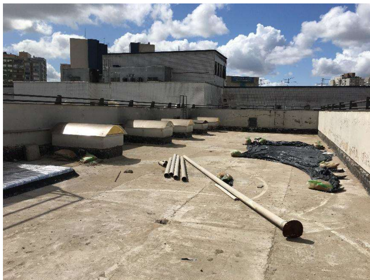
Foto 03 – Rasgos na alvenaria para engaste da manta.
