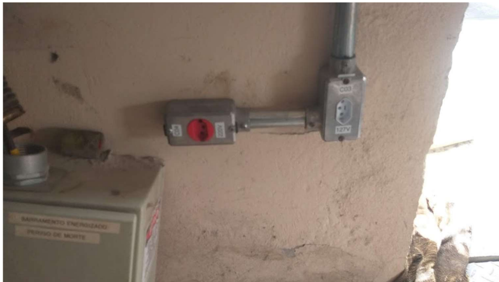
Foto 09 - Tomadas de sobrepor em condutele.
